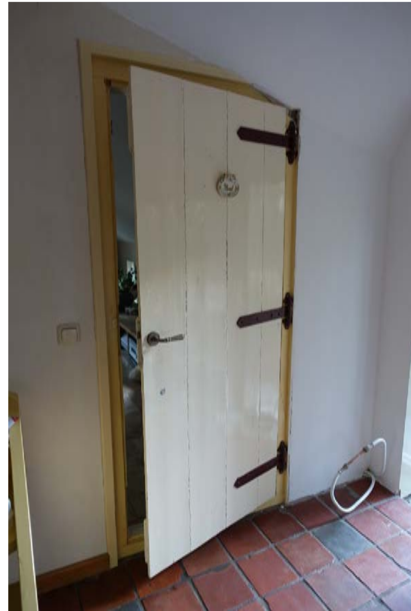
In het herbouwde achterhuis herplaatste oorspronkelijke opgeklampte deur.
