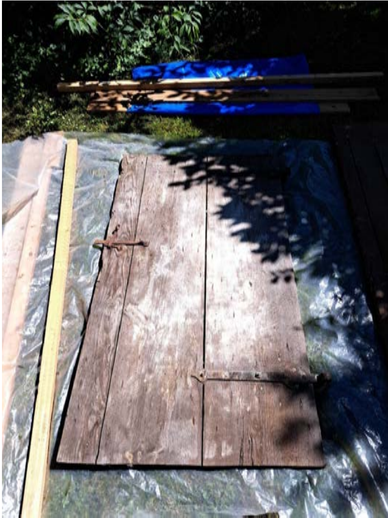
Op het terrein aanwezige opgeklampte deur.
