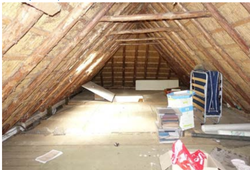
Overzicht dakconstructie richting de achtergevel.
