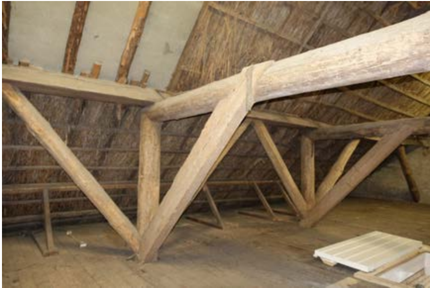
Gebinten onder het rechter dakvlak van het achterhuis.
