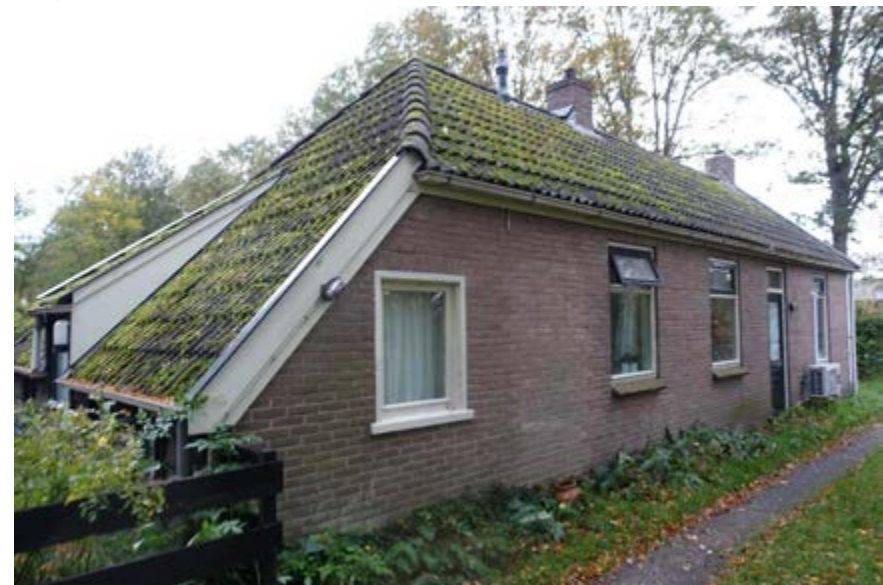
De volledig vernieuwde linker zijgevel. Ook de dakbedekking is niet historisch.
