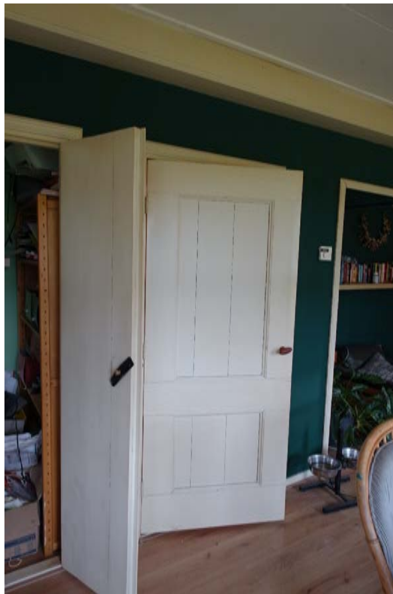
Hergebruikte oudere deuren van de bedsteden en doorloop.
