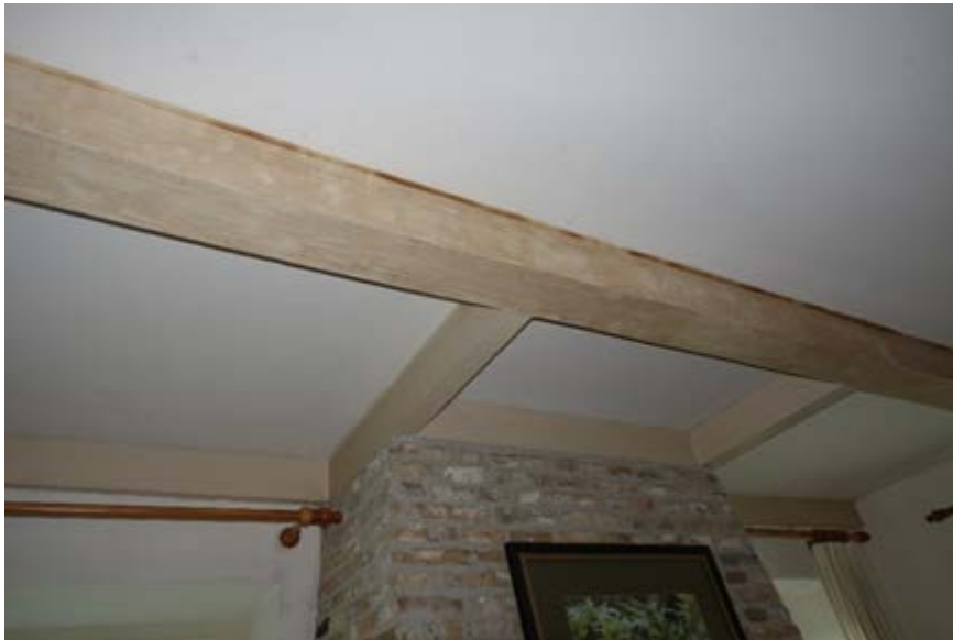
Deels werden uit het pand afkomstige 'Friese geeltjes' hergebruikt
