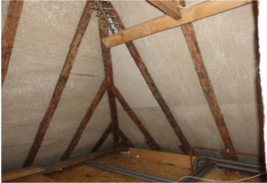
Alleen bij het achterste deel van de dakconstructie zijn nog de rondhouten sporen zichtbaar. Rechtsboven is de latere rechthoekige gording met tussenregel zichtbaar.
