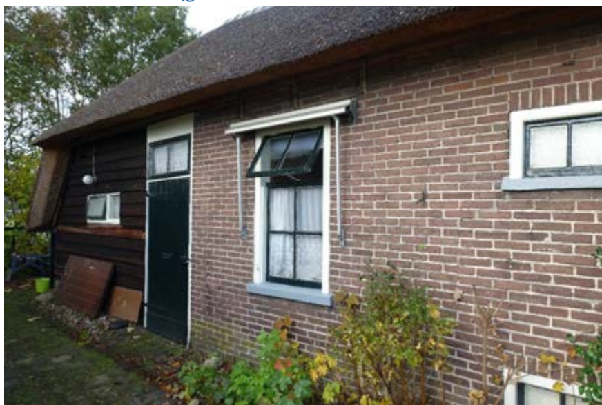
Linker zijgevel van het vroegere bedrijfsgedeelte. Het rechterdeel werd in baksteen uitgevoerd en tegelijkertijd werd hier het slaapkamervenster ingevoegd.
