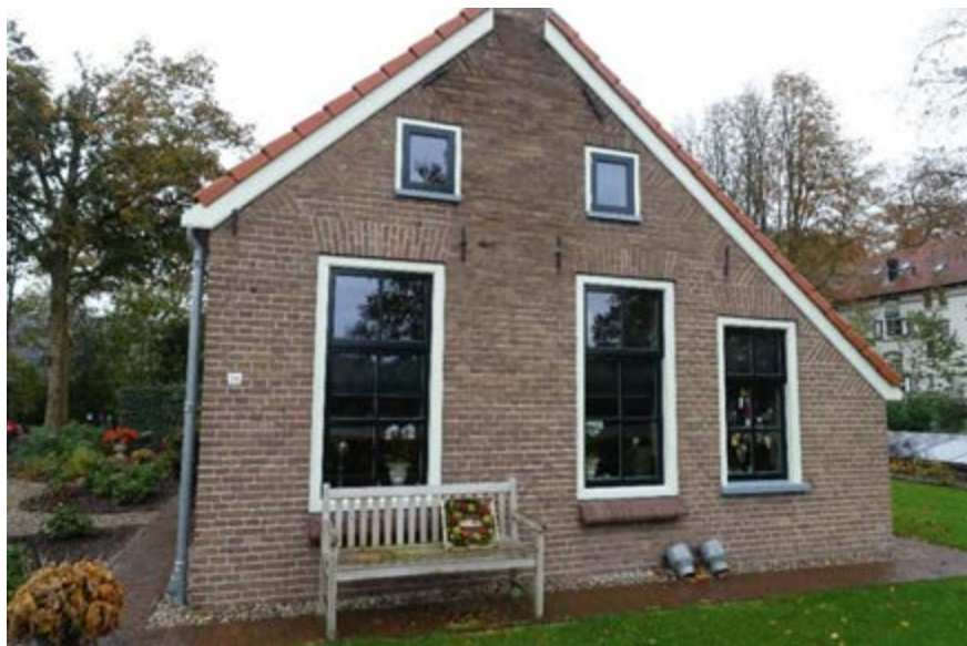
Overzicht voorgevel. De kozijnen werden in 2021 vervangen.
