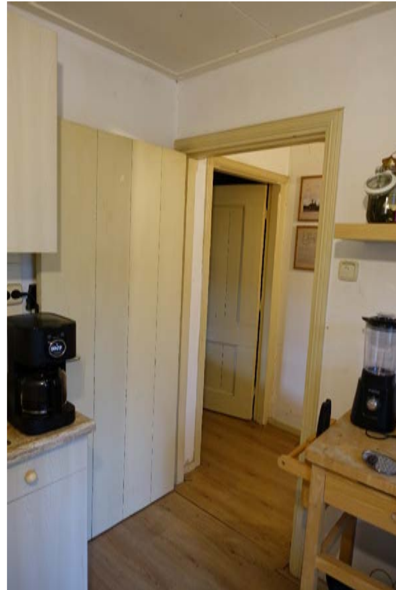
Historische kozijnen met een biljoenprofiel en opgeklampte deuren uit de vroege twintigste eeuw.
