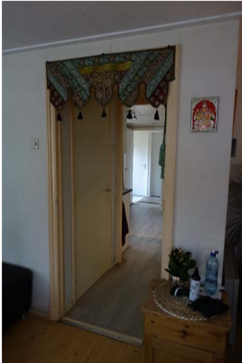
Restant van de historische structuur van de doorloop en (verwijderde) bedstede met onderliggende kelder. Alle delen zijn thans recent afgewerkt.
