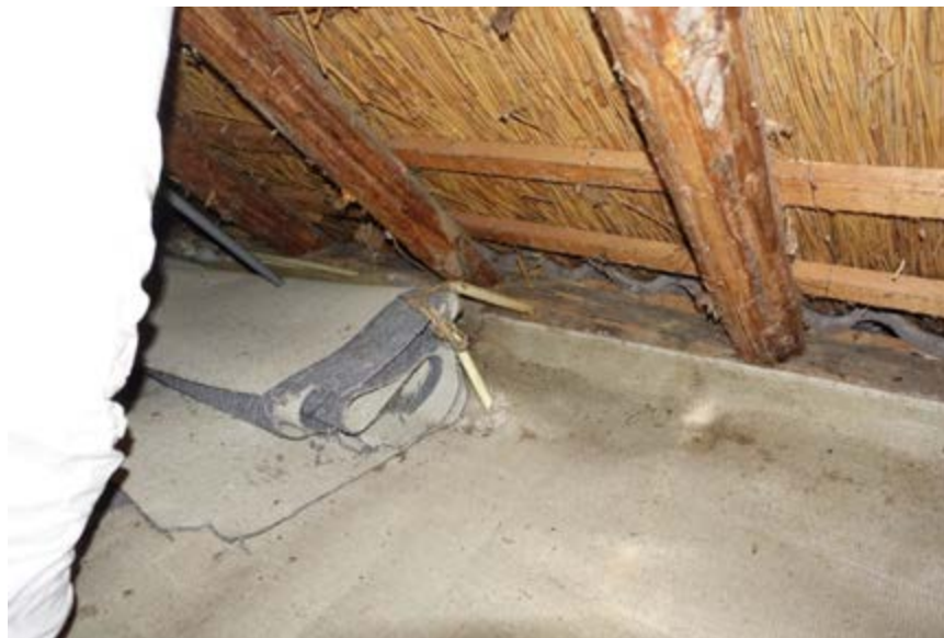
Het lessenaardak van de zijkamer loopt tegen de buitenzijde van de bestaande muurplaat. De betonpannen zijn hier zichtbaar.
