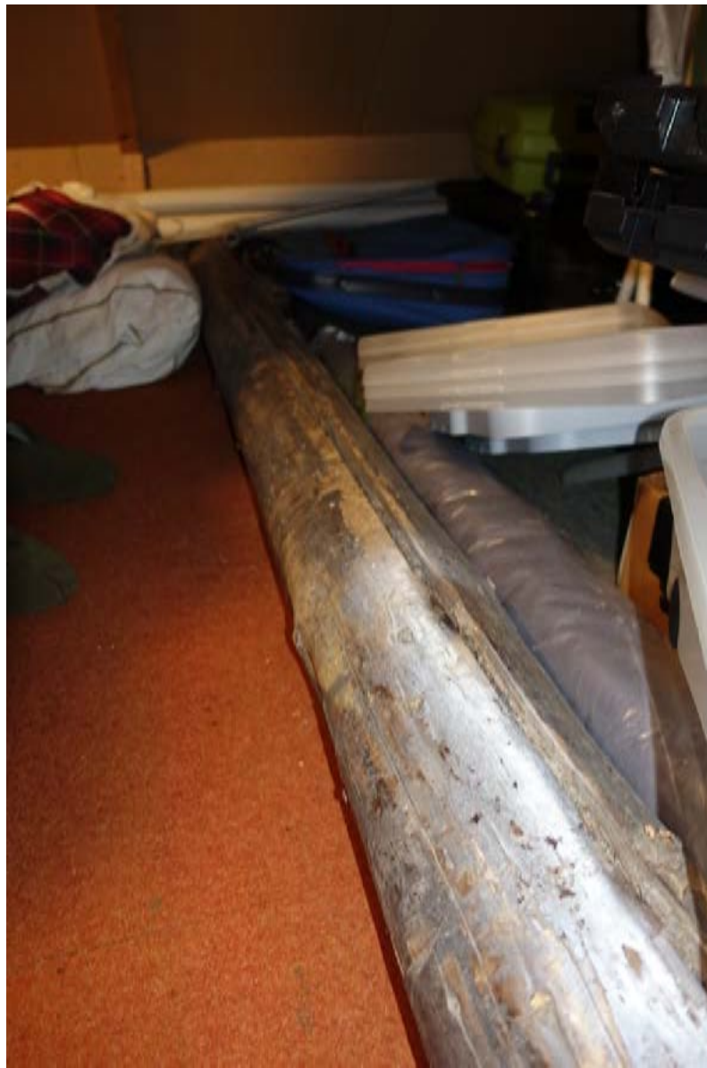
De rondhouten dekbalk ligt boven de latere verdiepingsvloer.
