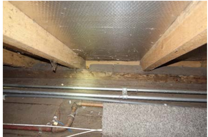
Recente sporen sluiten aan op de oorspronkelijke rechthoekige muurplaat.
