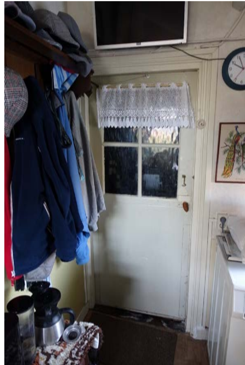
Paneeldeur met vierruits glasopening in de achterwand van de keuken.
