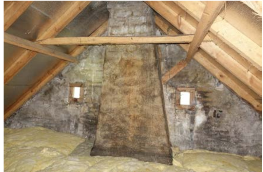
Historisch rookkanaal tegen de voorgevel. De dakconstructie is geheel vernieuwd.
