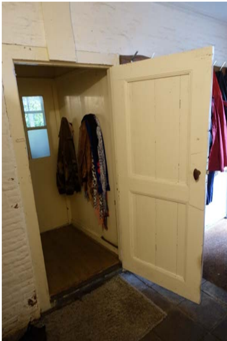
Opgeklampte deur met spiegelklampen tussen de doorloop en het vroegere bedrijfsgedeelte.
