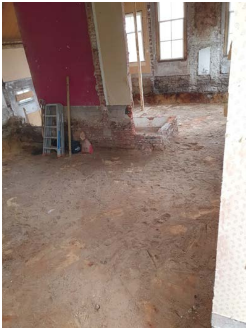
Foto interieur richting de voorgevel, tijdens de renovatie. Foto Herman Bremmer.
