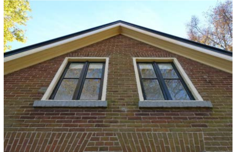
Oorspronkelijke vensters met stolpramen op de verdieping.
