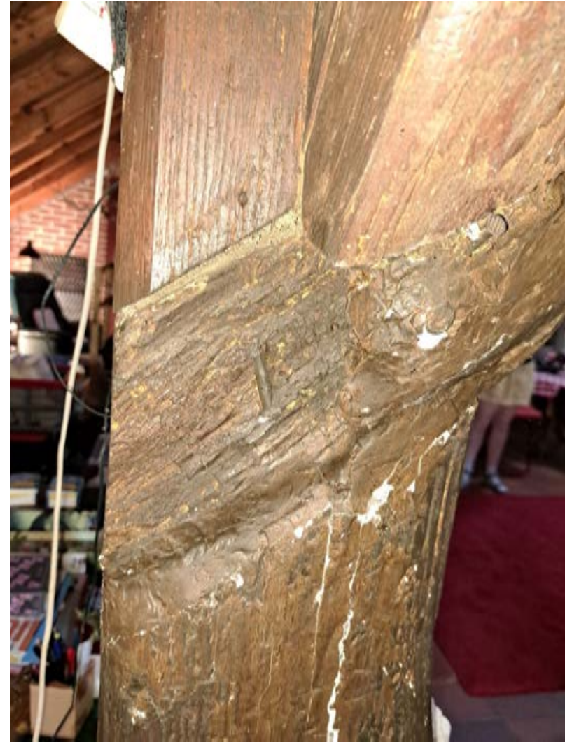
Detail aansluiting korbeel op gebintstijl.
