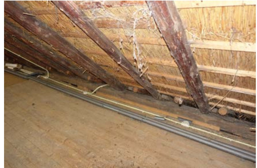
Muurplaat onder het rechter dakvlak. De sporen van het lessenaardak van de zijkamer zijn hierop gelegd. De onderliggende muur is verdwenen.
