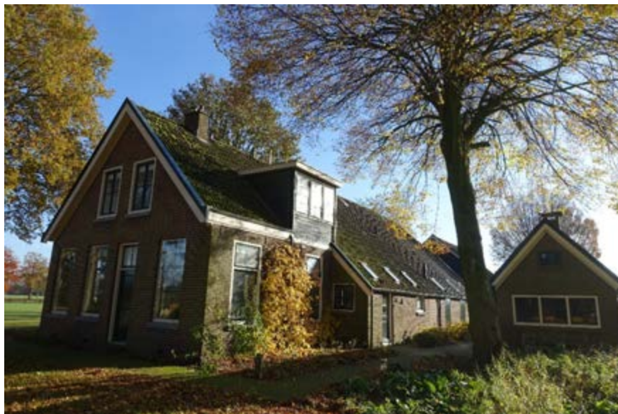
Rechterzijde woning, met rechts de schuur uit 1944.
