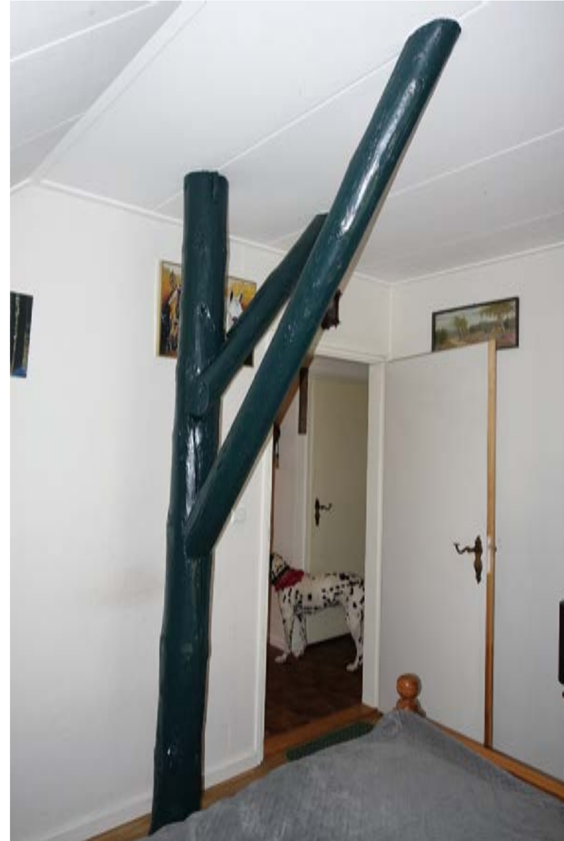
Rechter gebintstijl van het dekbalkgebint, gezien vanaf de achtergevel.
