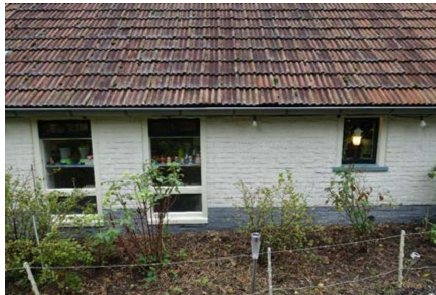
Middendeel van de linker zijgevel, met rechts ouder muurwerk met een niet-oorspronkelijk venster.
