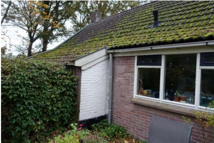
Naast het terugliggende middendeel van de rechter zijgevel tekent zich nog de oude contour af op de achterzijde van de zijkamer.
