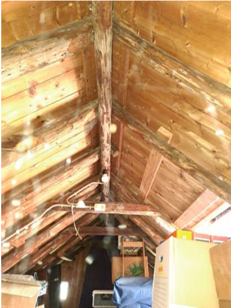
Boven het oorspronkelijke woongedeelte zijn rondhouten sporen aanwezig.
