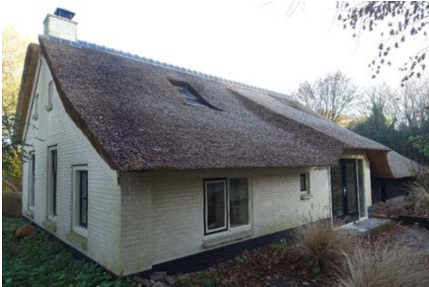
Overzicht voorgevel en rechter zijgevel.
