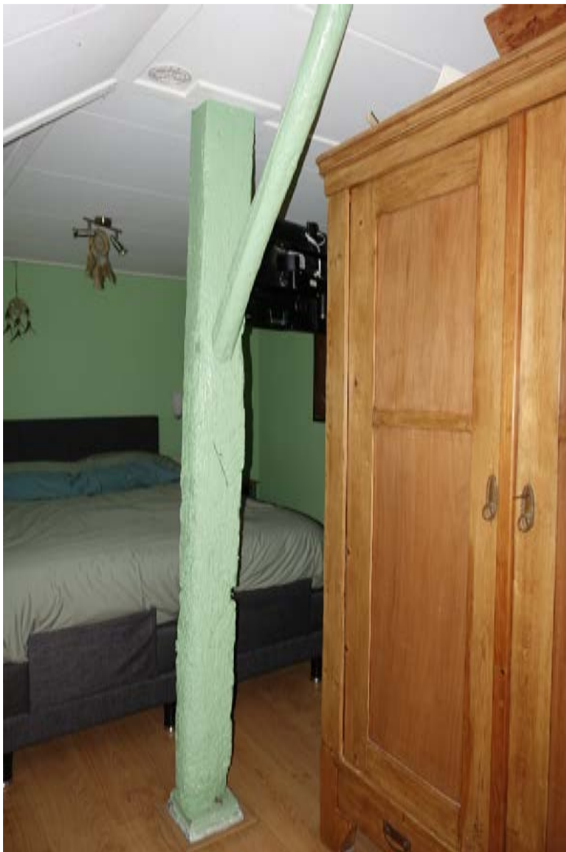
Rechter gebintstijl van het voorste gebint. Hier is één rondhouten windschoor aanwezig. Het rechthoekige korbeel is afgezaagd.
