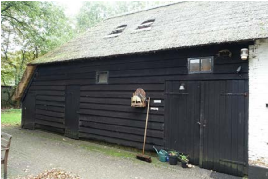
Vernieuwde houten gevel van het bedrijfsgedeelte.
