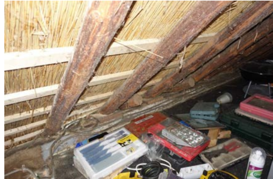
De rondhouten sporen van de uitgebouwde keuken steken over de oorspronkelijke muurplaat tussen de sporen van de hoofdkap.
