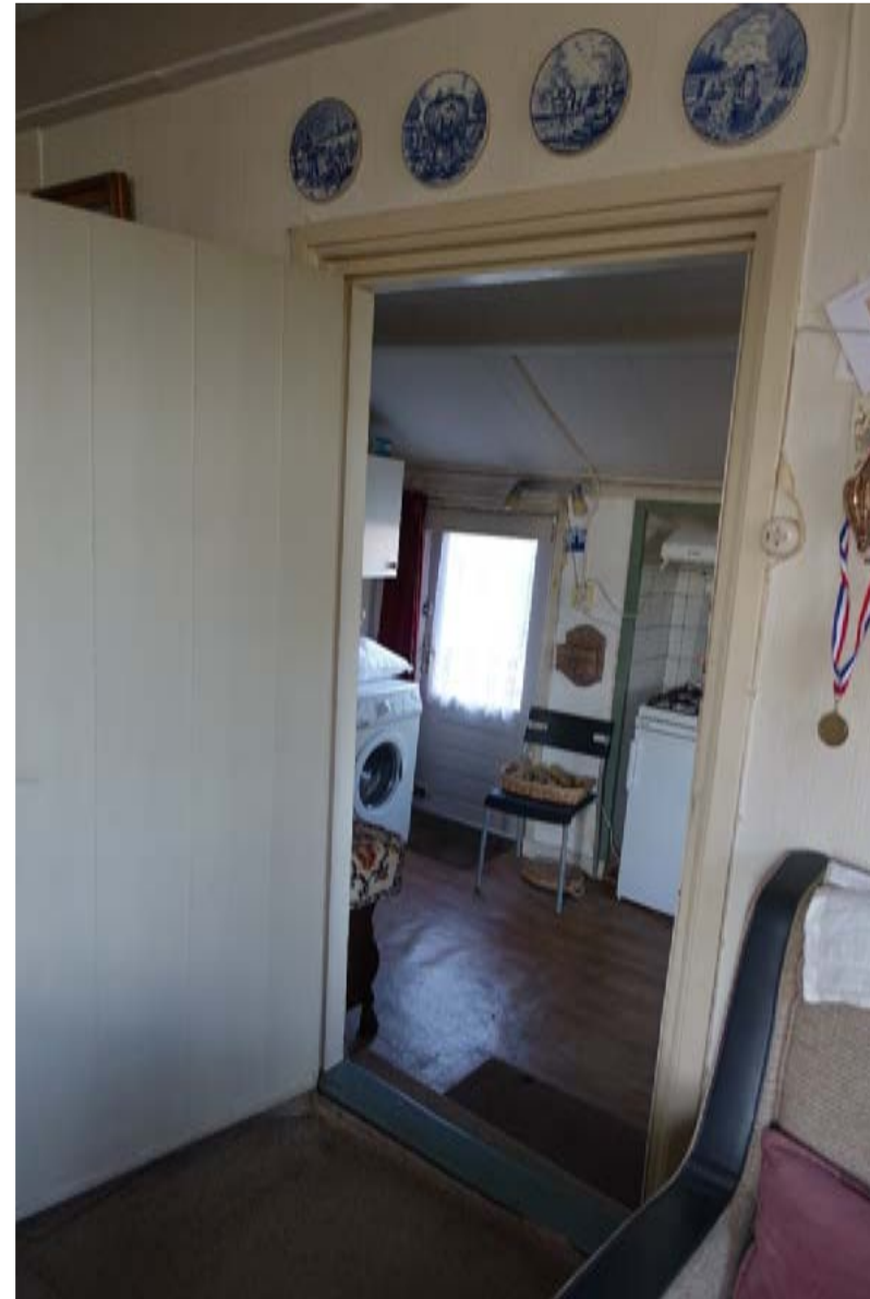
Deuropening met een historisch kozijn met opgeklampte deur tussen de woonkamer en de later aangebouwde keuken.
