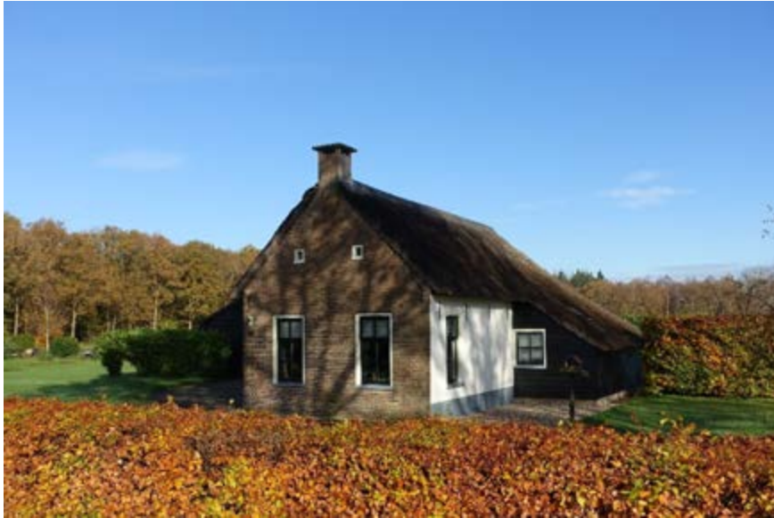
Overzicht van de voorzijde van de woning, waarbij goed de oorspronkelijke opzet zonder zijkamer zichtbaar is.
