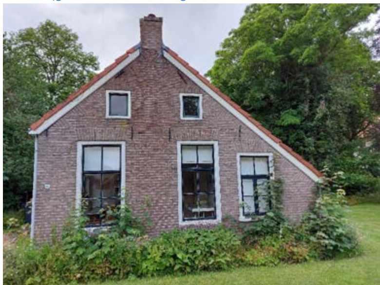
Foto voorgevel voordat de oorspronkelijke kozijnen werden vervangen. Foto Herman Bremmer.
