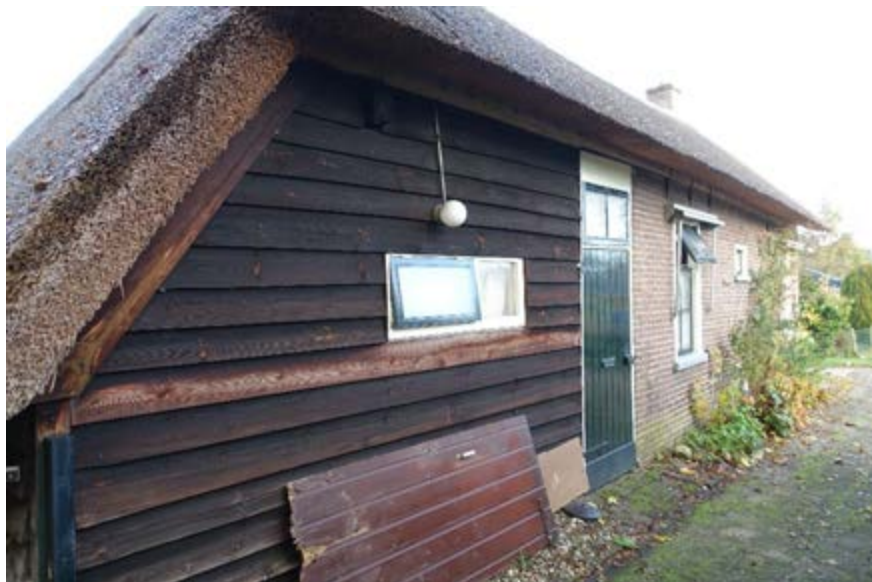
Overzicht van de linker zijgevel.
