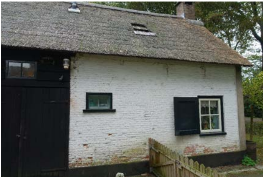
Gemetselde gevel van het oorspronkelijke woongedeelte.
