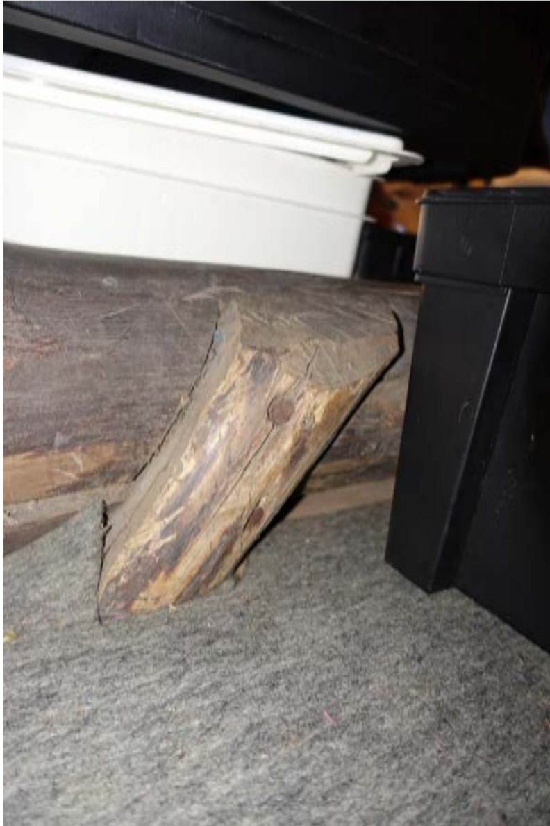
Gespijkerde verbinding tussen de dekbalk en het korbeel.
