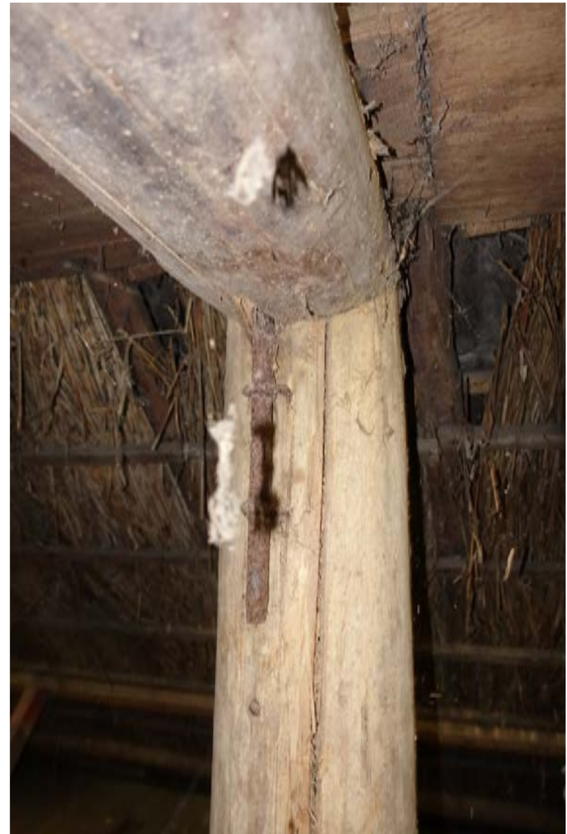
Detail gesmede pen in de onderzijde van de dekbalk. Deze pen is met twee zware krammen met de gebintstijl verbonden.
