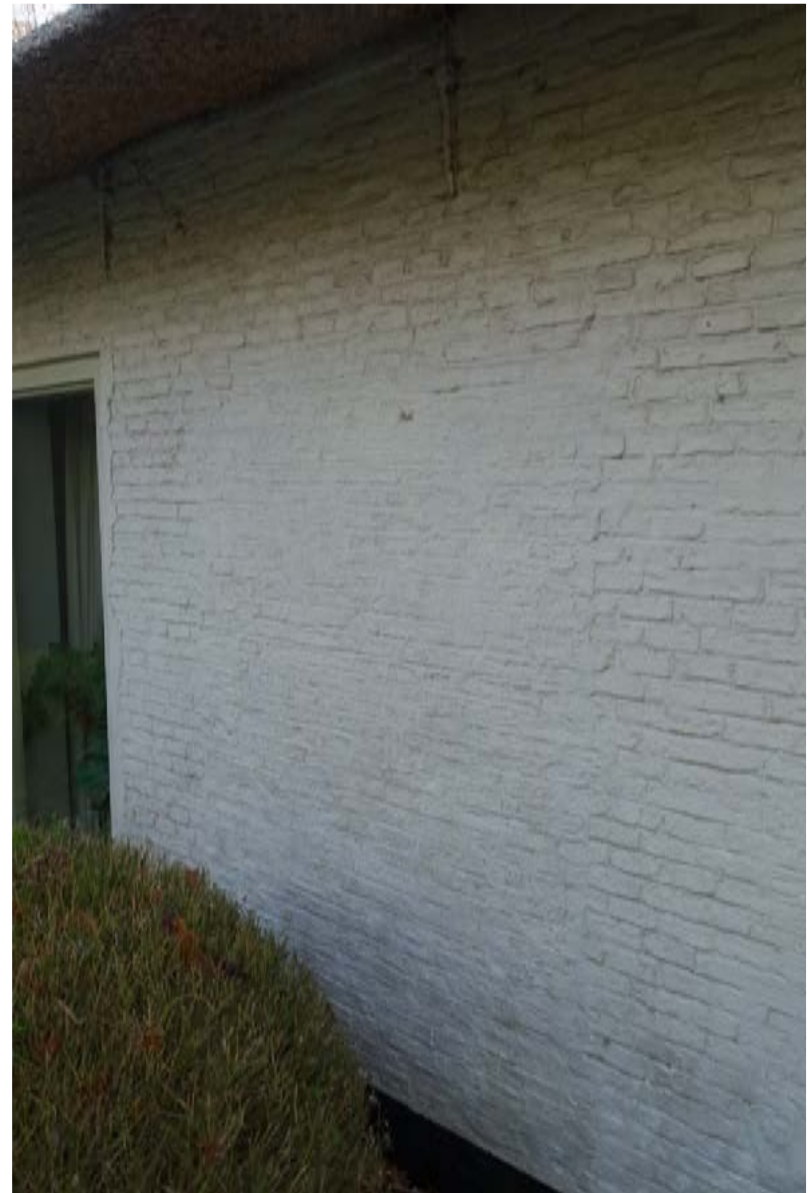
Dichtgemetselde deuropening in de linker zijgevel.
