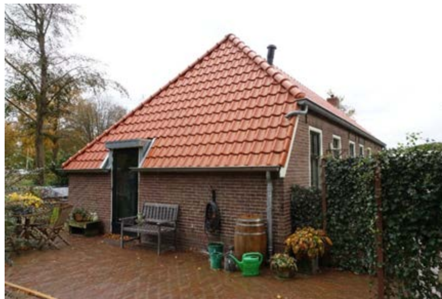
Achtergevel met recente deuropening.
