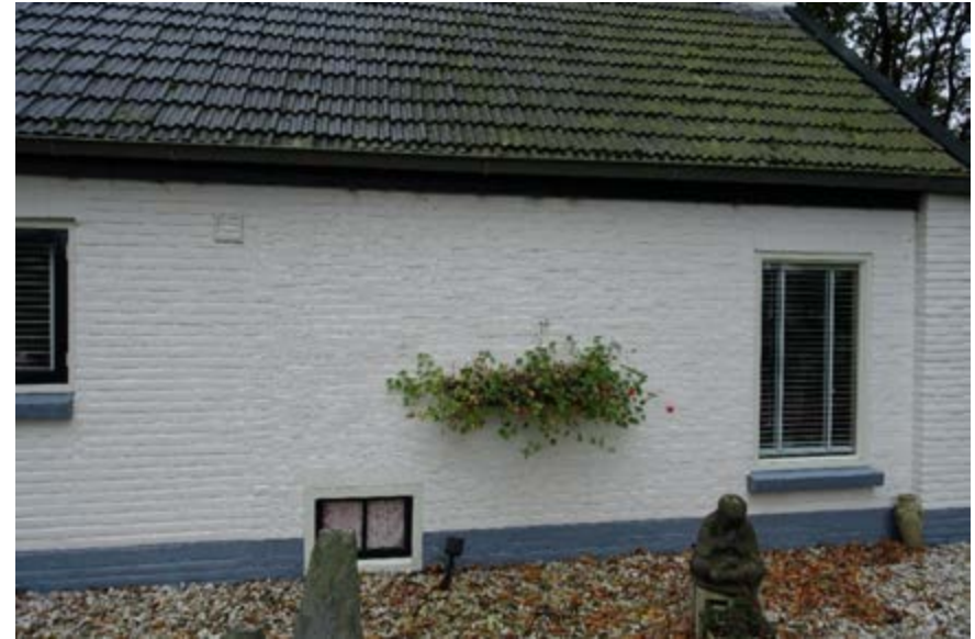
Ouder muurwerk (XXa) van de linker zijgevel van het oorspronkelijke woongedeelte.
