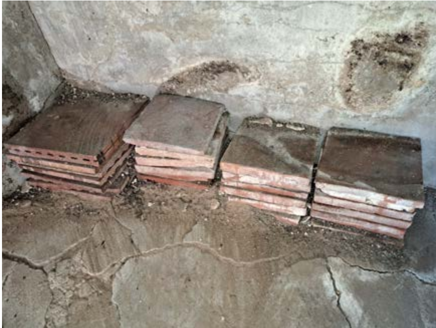
In het bakhuisje opgeslagen plavuizen.
