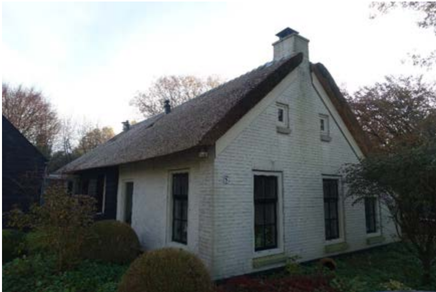
Overzicht voorgevel en linker zijgevel.
