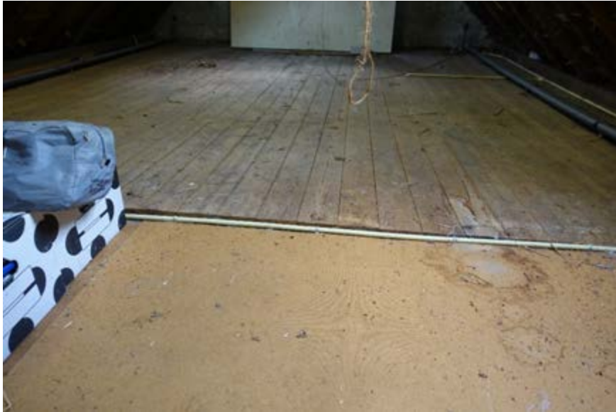
Recente vloerdelen en plaatmateriaal op de verdieping.
