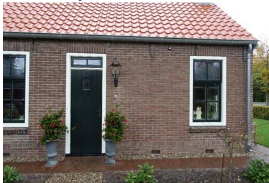
Rechterzijde van de linker zijgevel, met bloktand op de gevelhoek.
