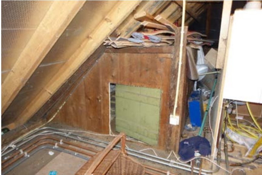
Opmerkelijke opkamer met houten wanden onder het linker dakvlak. Het plafond werd verlaagd en de onderliggende kelder is verwijderd.
