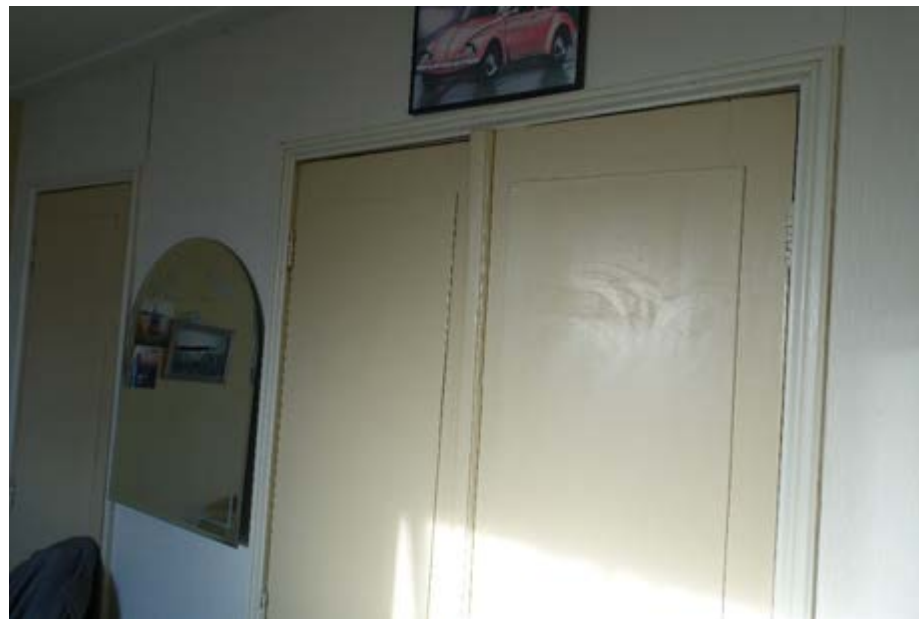
De vaste kasten aan de rechterzijde van de slaapkamer hebben dezelfde omlijstingen. De paneeldeuren zijn afgeplaat.
