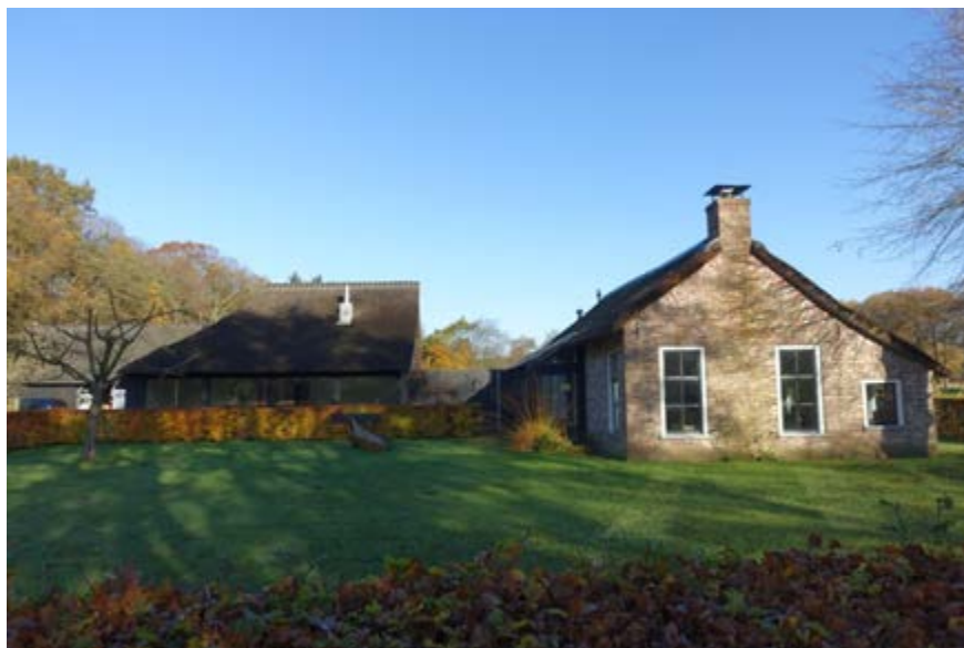
Hooiweg 5 met een uitbreiding met een traditionele hoofdvorm, verbonden met een lage verbindingsgang.
