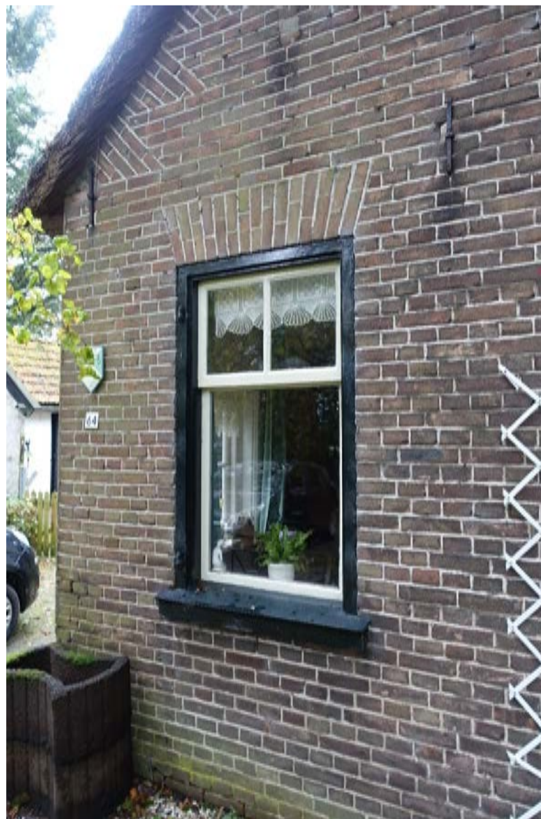
Herplaatst oorspronkelijk kozijn in de voorgevel.
