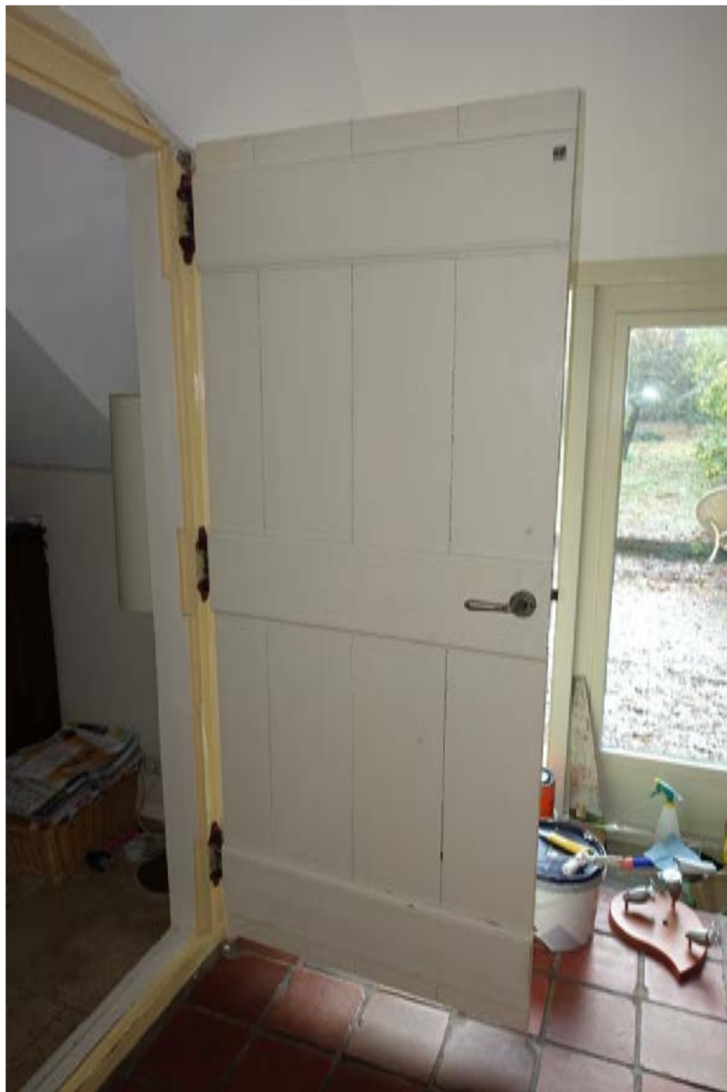
Klampzijde van de hergebruikte deur.
