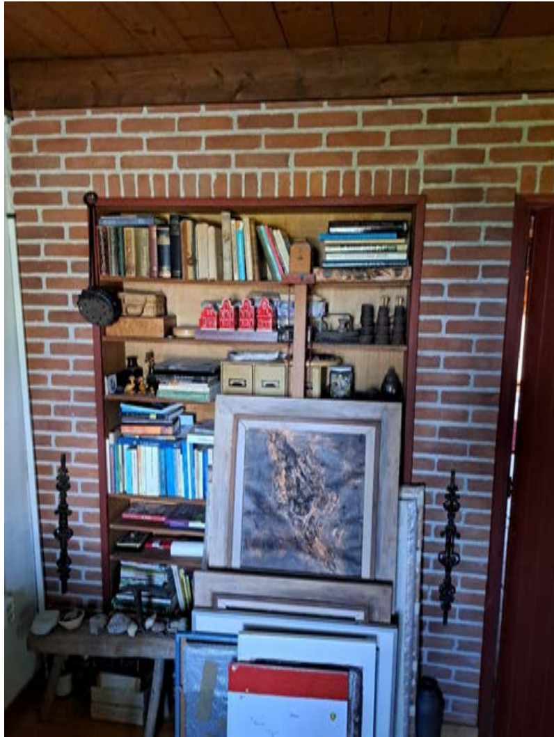
In schoon metselwerk vernieuwde scheidingsmuur tussen het voormalige woongedeelte en bedrijfs gedeelte.
