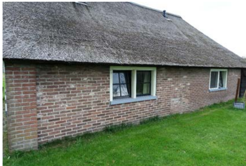
Overzicht van de rechter zijgevel. Het linkerdeel heeft hergebruikte steen.
