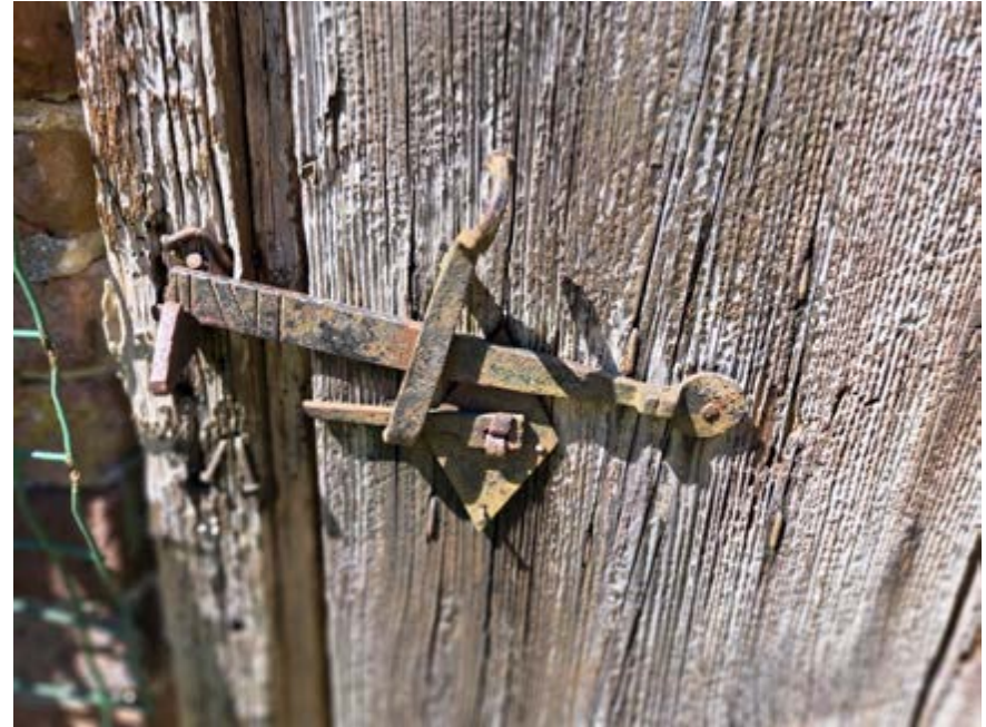
Detail klinkstel van de opgeklampte deur van het bakhuisje.
