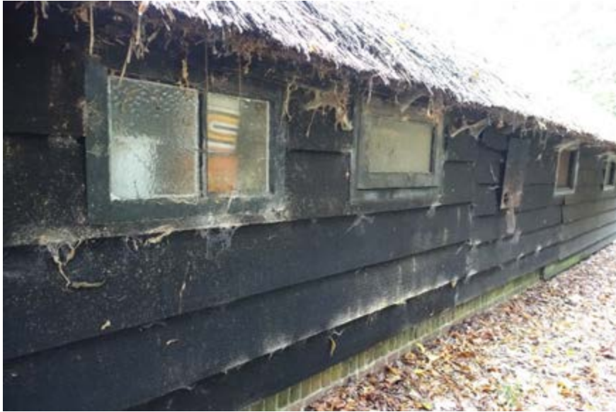
De vernieuwde houten gevel van het bedrijfsgedeelte op een voetsmuur van machinale baksteen.
