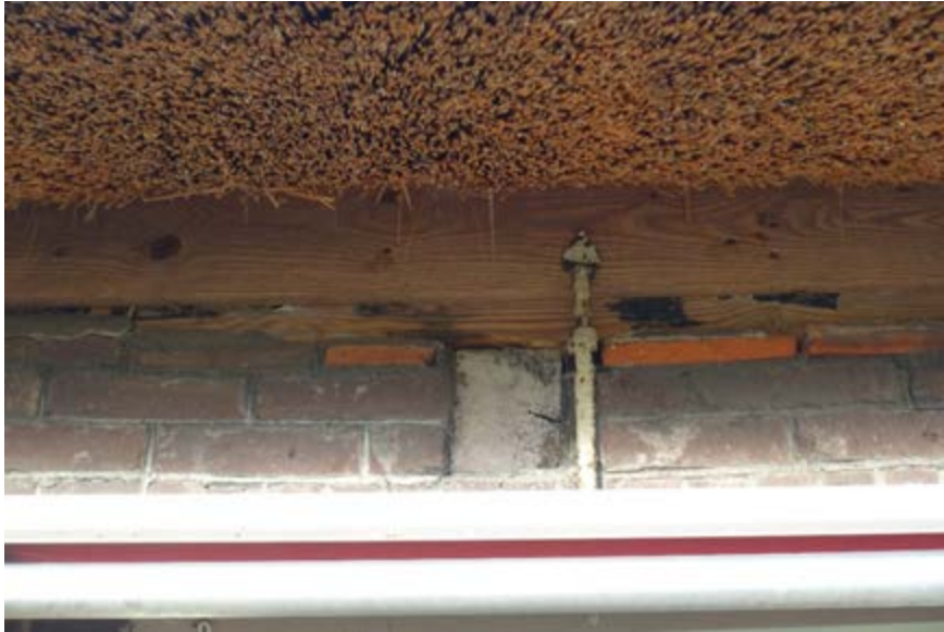
De rechthoekige balkkoppen van de oorspronkelijke verdiepingsbalklaag zijn zichtbaar boven de linker zijgevel.
