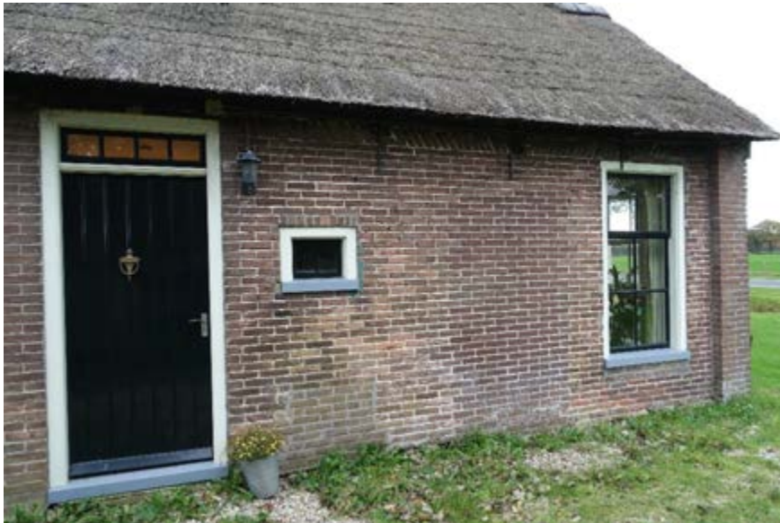
Het oudere rechterdeel heeft in het midden een dichtgezette deuropening.
