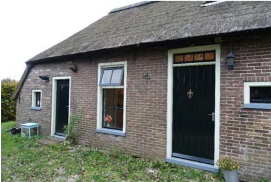
Linkerzijde van de linker zijgevel. Het zichtbare deel is in drie fasen tot stand gekomen.
