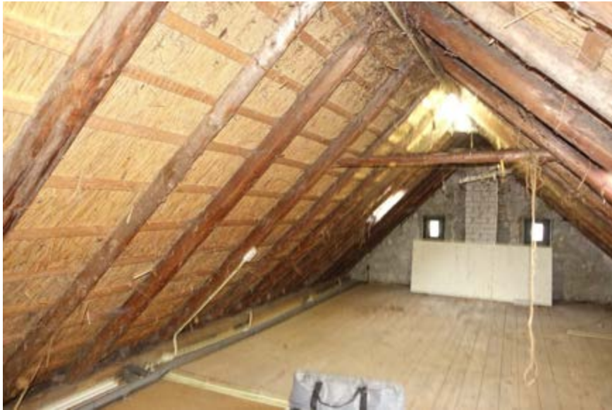
Overzicht dakconstructie richting de voorgevel.
