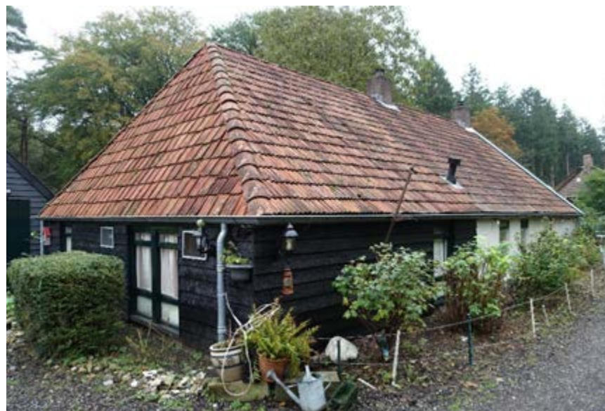
Overzicht achtergevel en linker zijgevel.
