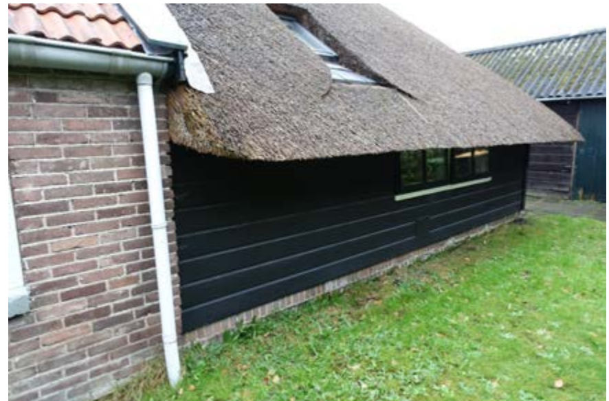
Vernieuwde houten rechter zijgevel van het vroegere bedrijfsgedeelte.
