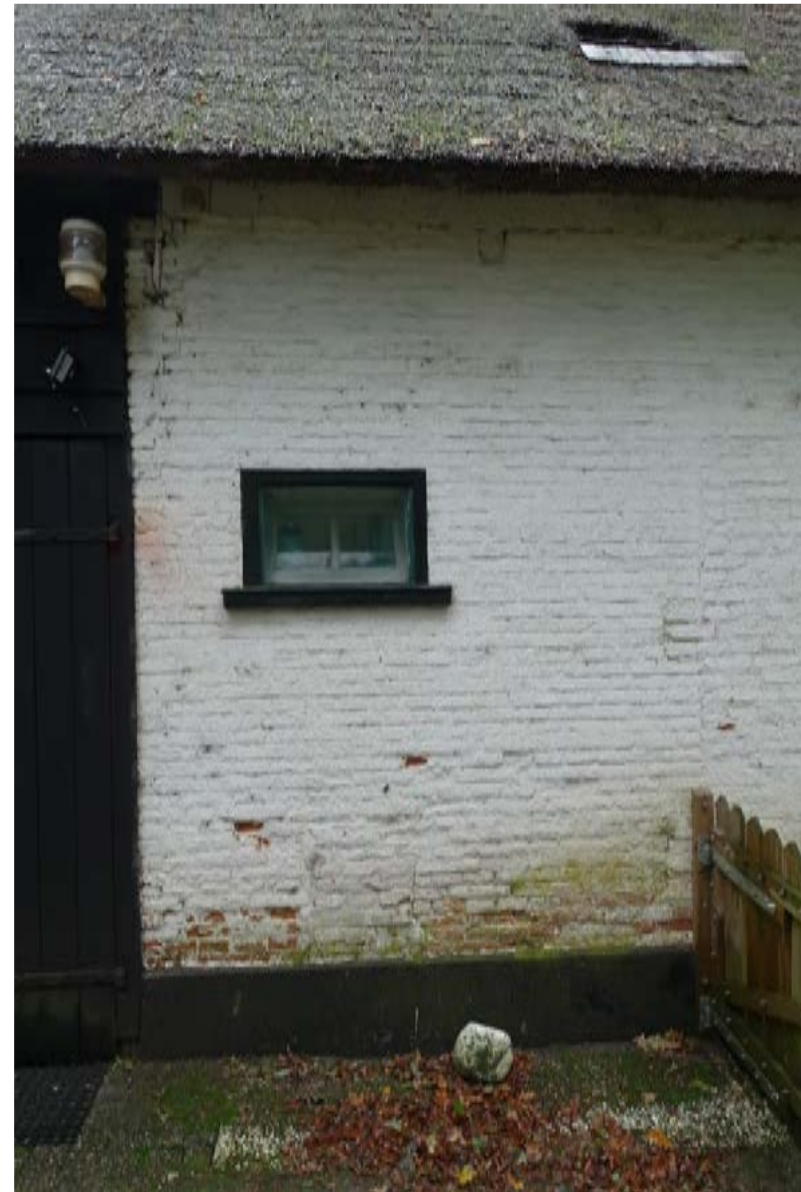
Middenzone met een herplaatst kozijn. Daaronder een dichtgezette smalle opening.
