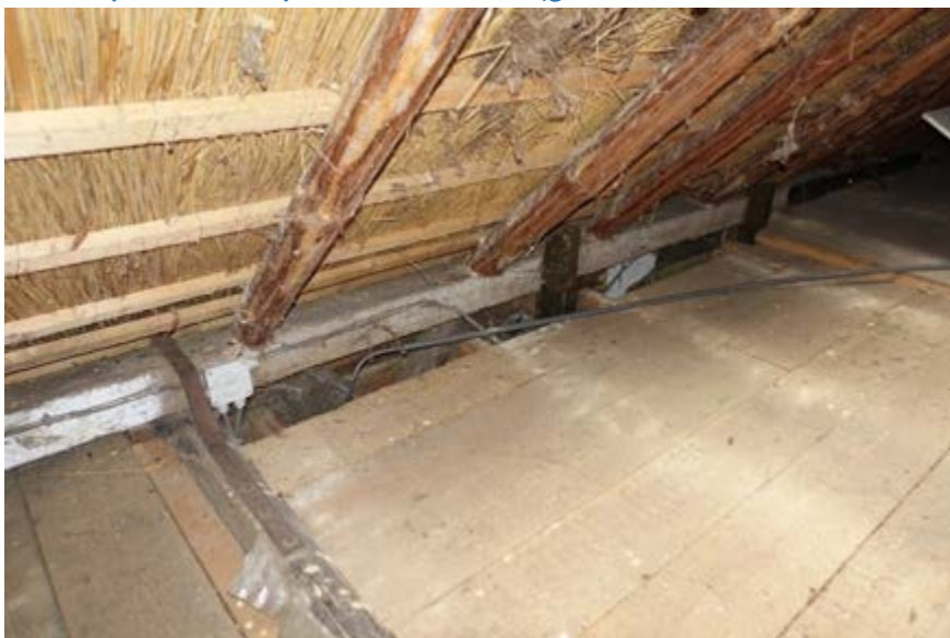
Gebintplaat boven de houten linker zijgevel van het achterhuis.
