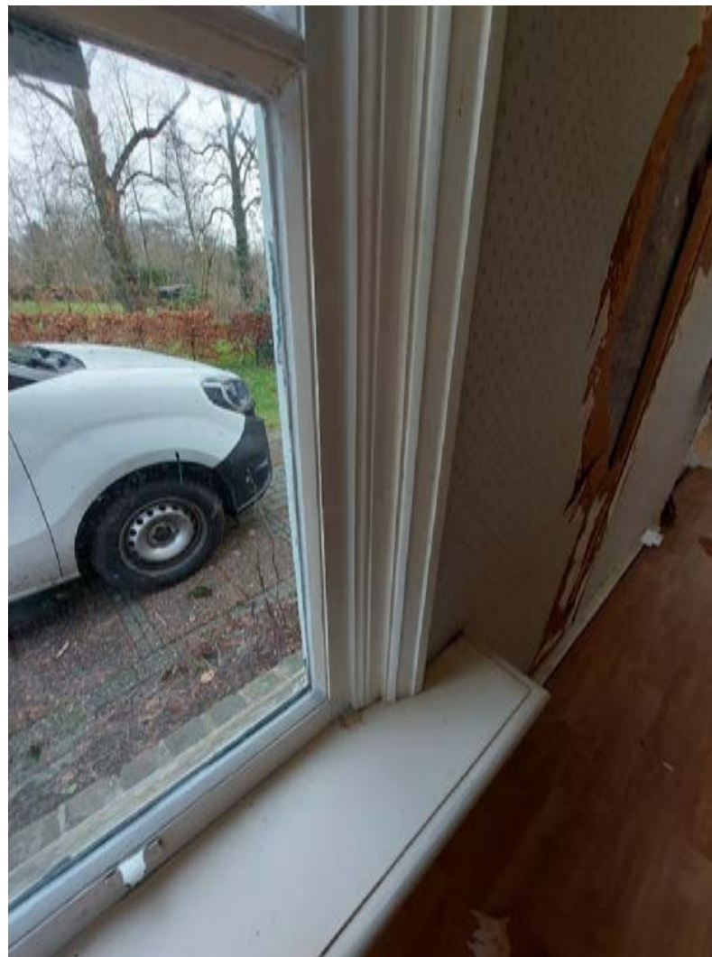
Detail van de oorspronkelijke geprofileerde omlijstingen en vensterbanken voor de renovatie in 2021. Foto Herman Bremmer.
