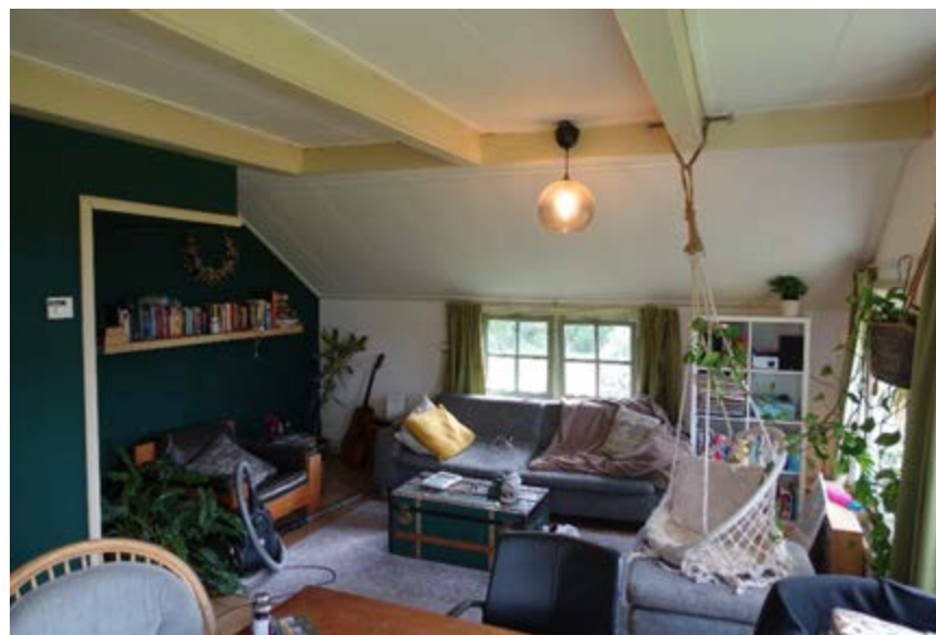
Omtimmerde enkelvoudige balklaag boven de woonkamer.
