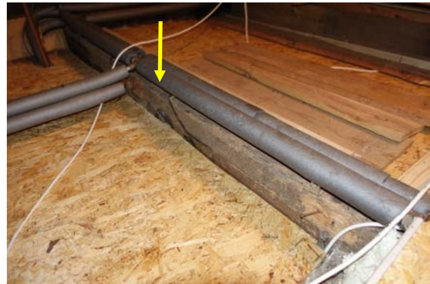
De rechthoekige dekbalk van het achterste gebint. Onder de pijl is de bovenzijde van het korbbeel herkenbaar.
