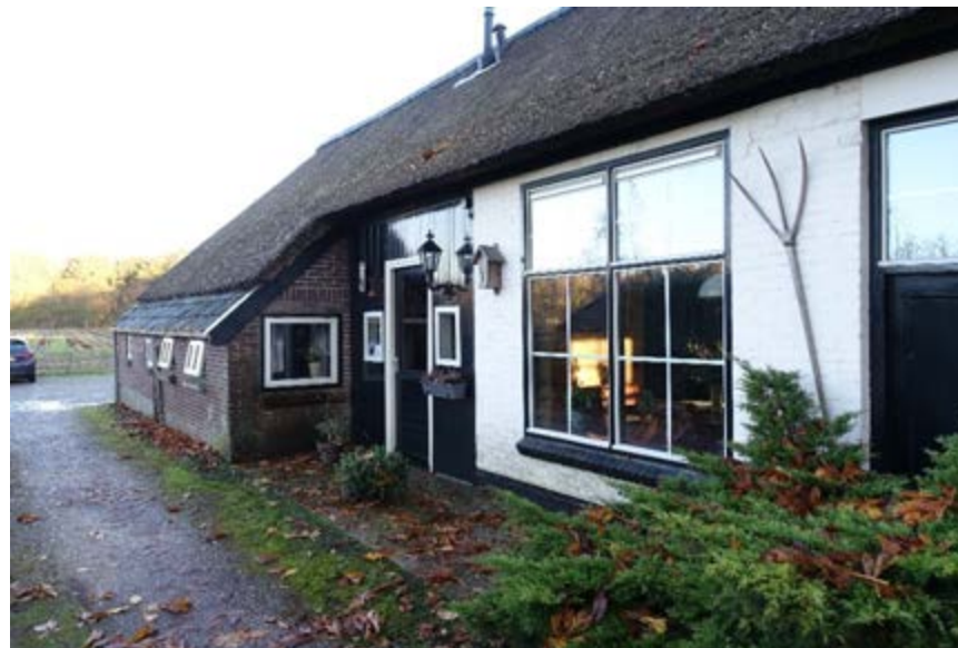
Overzicht rechter zijgevel. Alleen het meest rechter deel is mogelijk oorspronkelijk, maar dit is door de gepleisterde afwerking niet zichtbaar.
