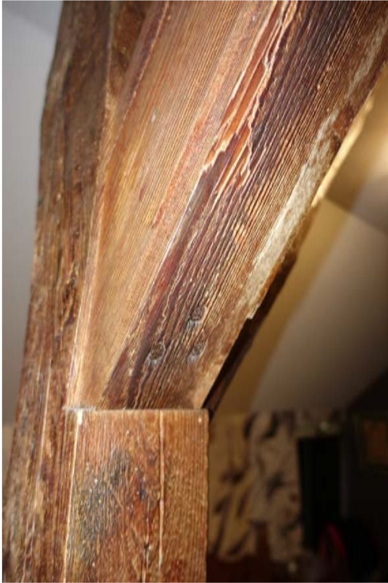
Met draadnagels bevestigd rechthoekig korbeel.
