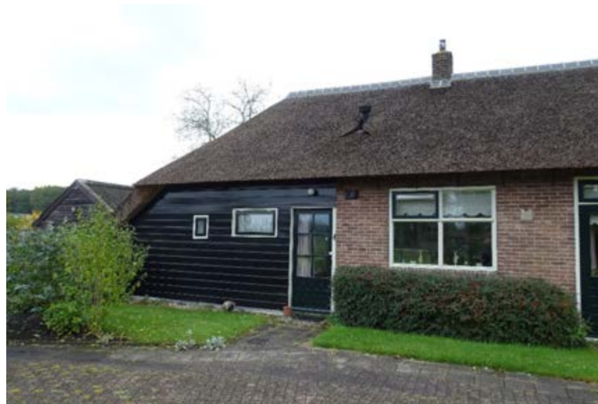
Ook bij de linker zij rabatdelen toegepast. Gevelopeningen hebben nieuwe invullingen.
