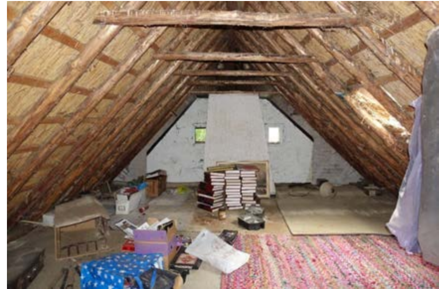
Overzicht dakconstructie richting de voorgevel.
