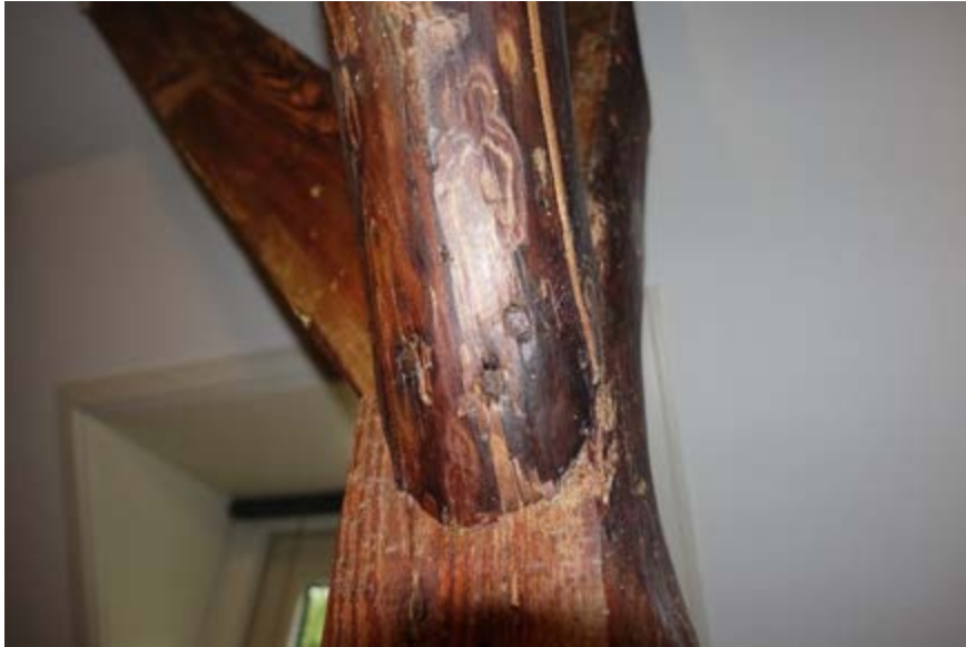
Met draadnagels bevestigde rondhouten windschoor.
