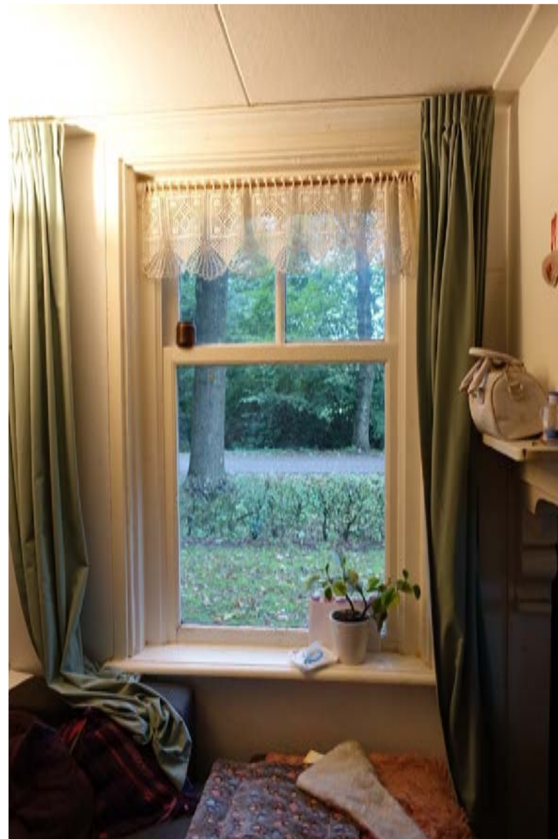
Venster met oorspronkelijk kozijn en raamhout. De omlijstingen zijn vernieuwd.
