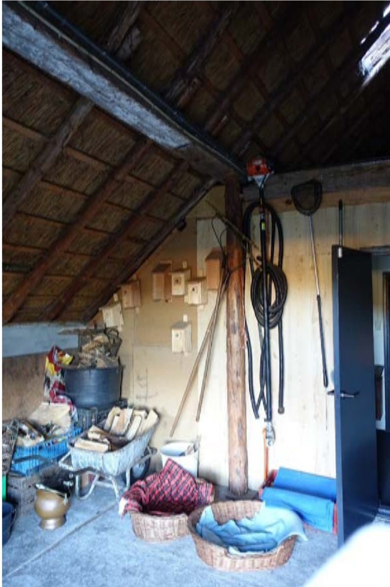
Gebint binnen de uitbreiding van het achterhuis. Dit gebint behoort tot de uitbreidingsfase.
