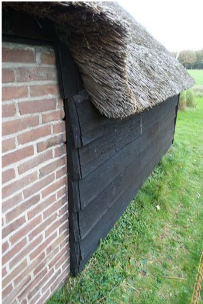
De rechterzijde van de gevel heeft een potdekseling met deels nog historische houten delen.
