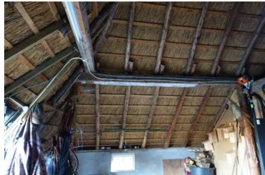
Dakvlak met vernieuwde rondhouten sporen.
