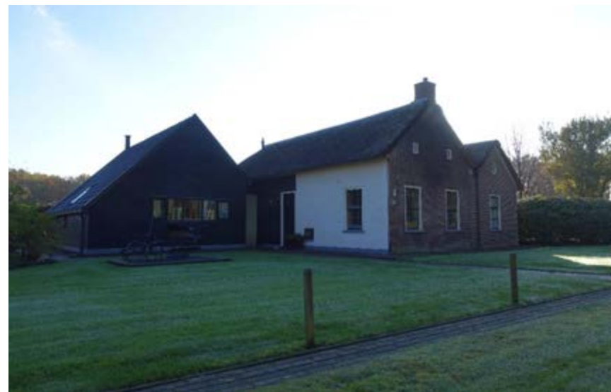
Majoor van Swietenlaan 35, met naast het bedrijfsgedeelte toegevoegde uitbreiding in asymmetrische eigentijdse vormgeving.
