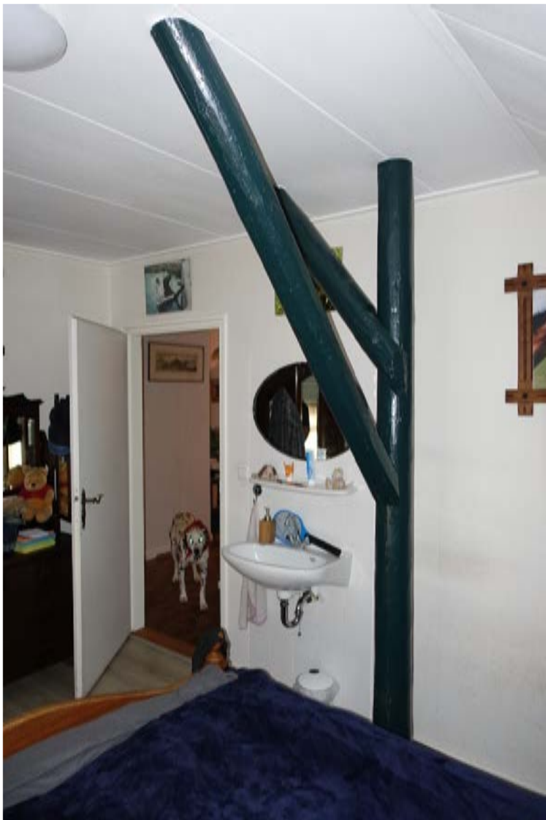
Linker gebintstijl van het achterste (enige) dekbalkgebint.
