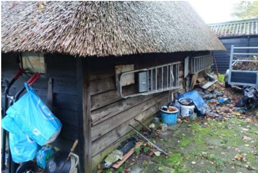
Overzicht van de achtergevel, met alleen in het midden een uitloopopening voor kippen.
