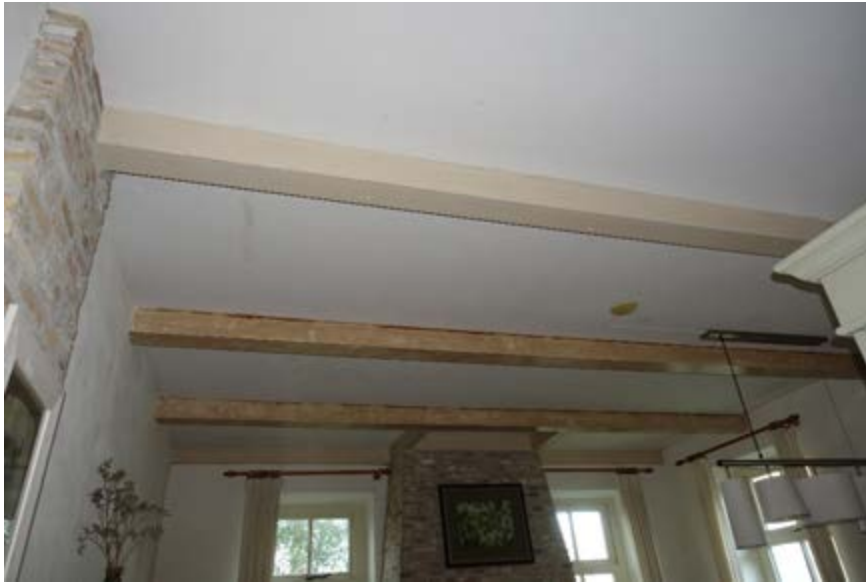
De twee donkerder gekleurde balken behoren tot de oorspronkelijke constructie.
