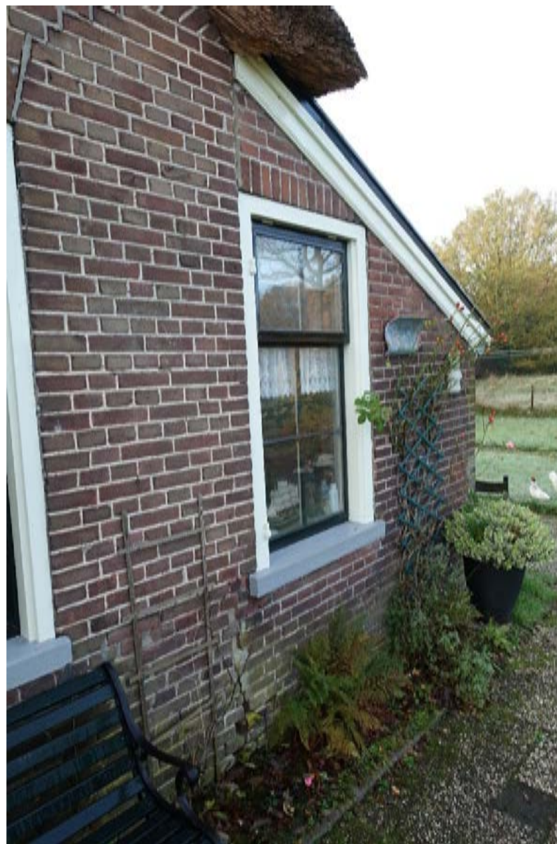
Voorgevel van de latere uitbouw aan de rechterzijde van het woongedeelte. De linker dagkant van het venster is de eerdere gevelhoek.
