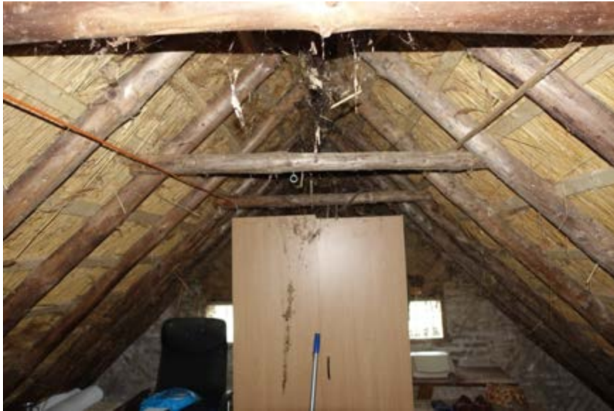
Overzicht van de dakconstructie richting de voorgevel.
