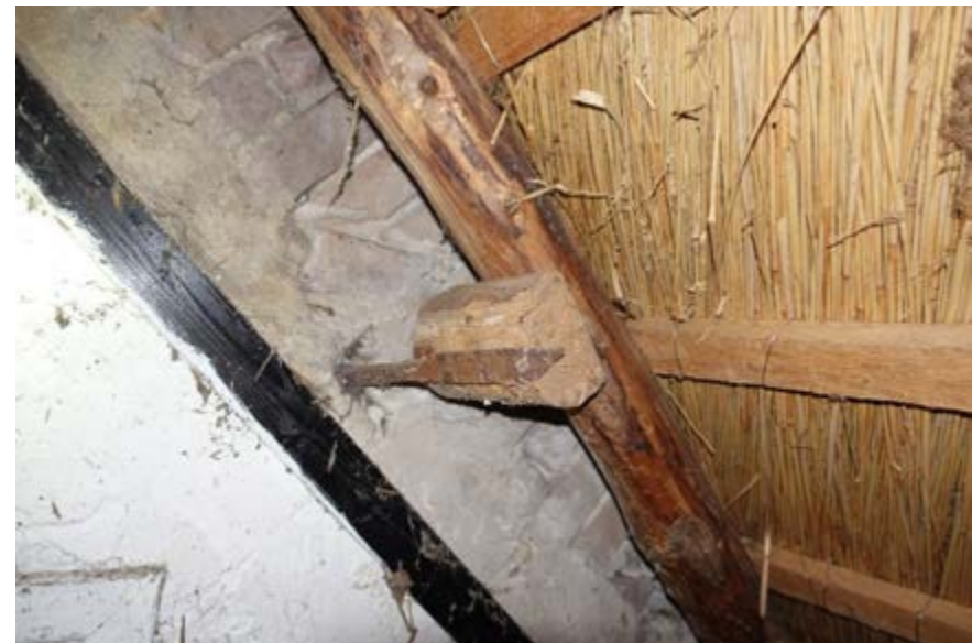
Oudere koppeling tussen de voorgevel en de vernieuwde rondhouten sporen.
