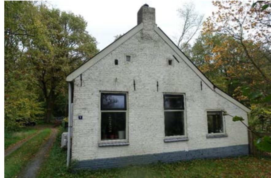
Overzicht van de voorgevel met historisch metselwerk (ca. 1900) maar vernieuwde kozijnen.
