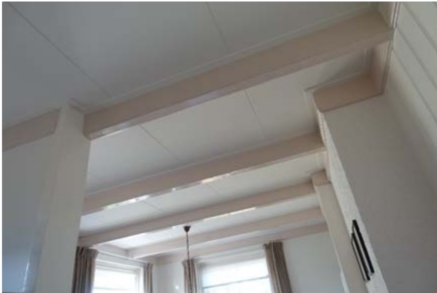
Enkelvoudige balklaag boven de keuken in het oorspronkelijke woongedeelte.
