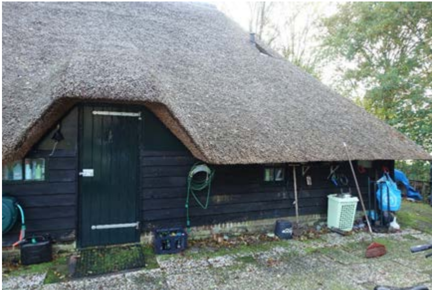
Vernieuwde houten gevel van het vroegere bedrijfs gedeelte.
