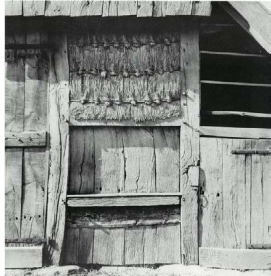
Een vakwerk wand van de schaapskooi bij de boerderij Lichtenberg in Volthe (Weerselo). Het gebouw heeft houten topgevels en de vakken zijn deels bekleed met hout en deels met vlechtwerk van stro. Foto Ger Dekkers. Maaskant (1976)
