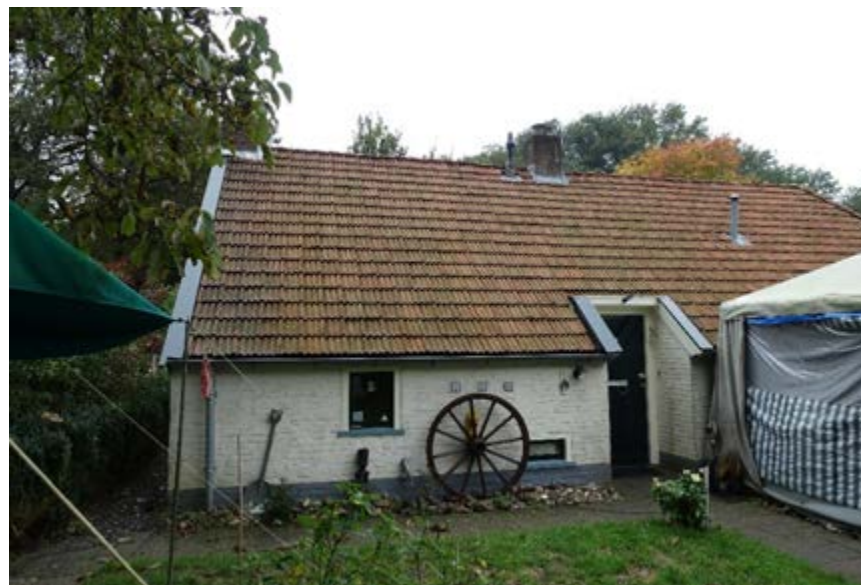
Alleen het voorste (linker) deel van de rechter zijgevel heeft ouder muurwerk.
