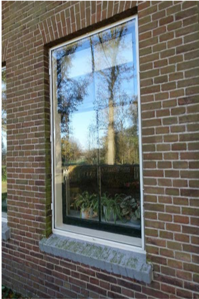
Eén van de oorspronkelijke kozijnen met zesruits schuiframen in de voorgevel.
