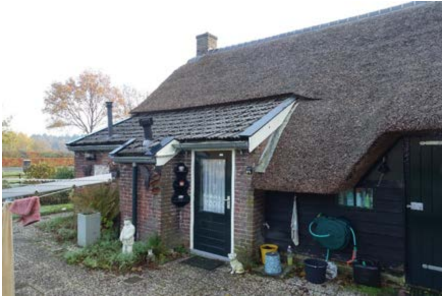
Rechter zijgevel van het uitgebouwde woongedeelte.
