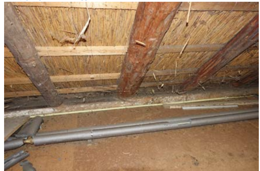
De muurplaat en gebintplaat hebben in het midden een schuine lip.
