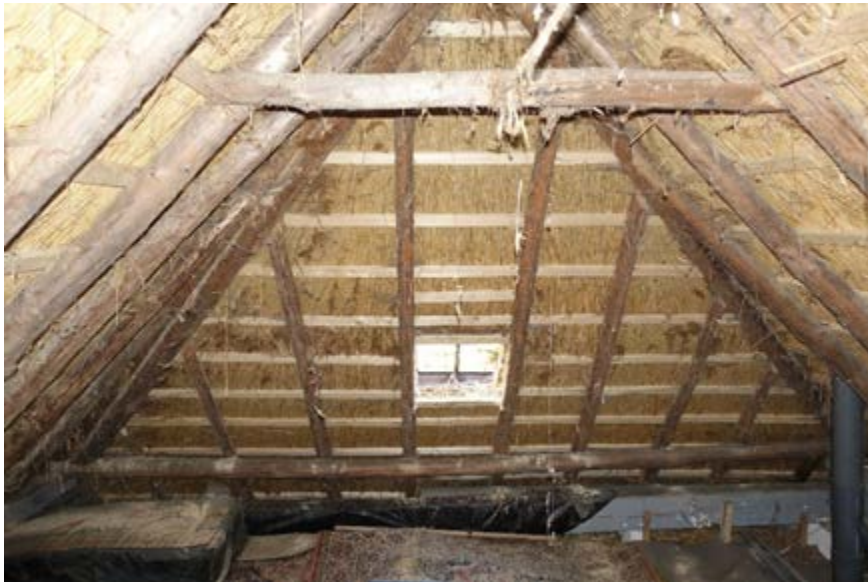
Overzicht van de dakconstructie bij het achterdakhak.
