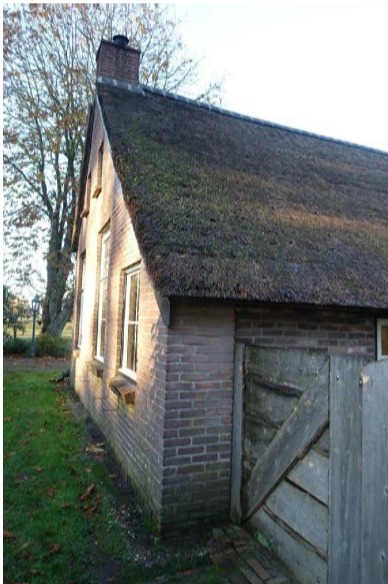
Bij de voorgevel is een halfsteens klamp rond de historische gevel geplaatst.
