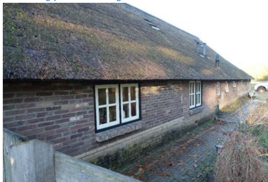
Overzicht van de in fasen vernieuwde rechter zijgevel.
