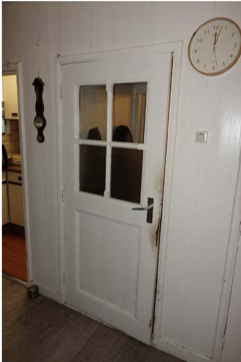
De deur naar de doorloop werd later voorzien van een vierruits glasopening.
