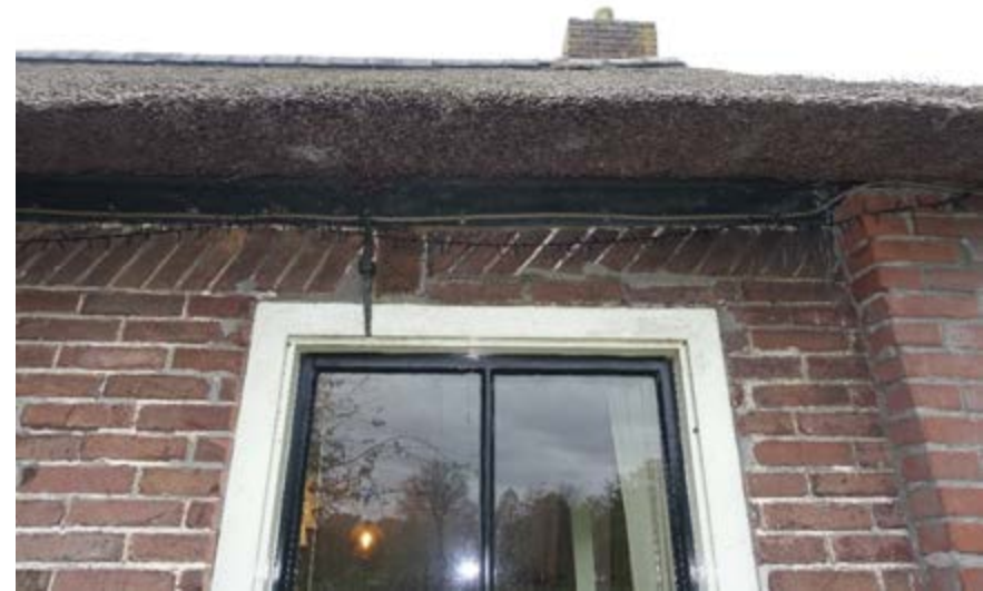
Het rechterdeel sluit met een stroomlaag aan op de muurplaat. Dit wijst erop dat de muurplaat aanwezig was voordat de huidige gevel werd gemetseld.
