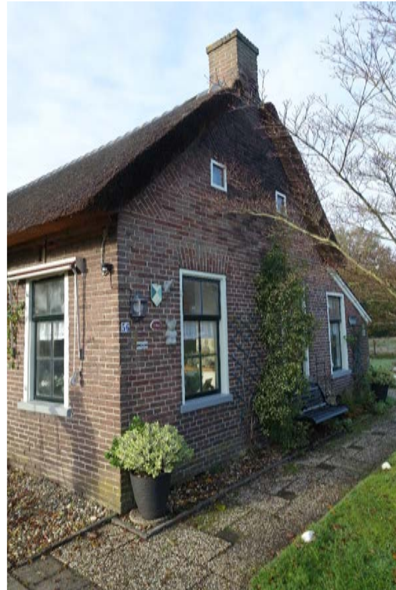
Overzicht van de voorgevel.
