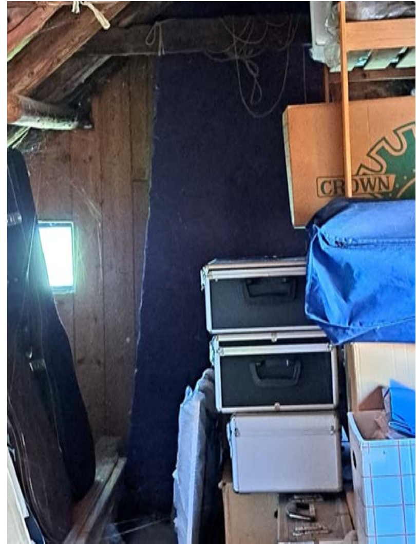
Detail aansluiting constructie met korte rondhouten gordingen op de voorgevel.
