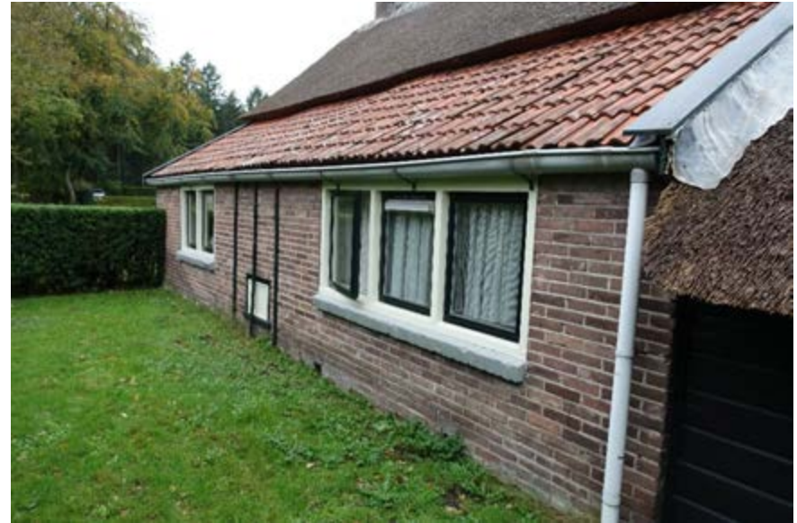
Overzicht van het verhoogde voorste deel van de rechter zijgevel.
