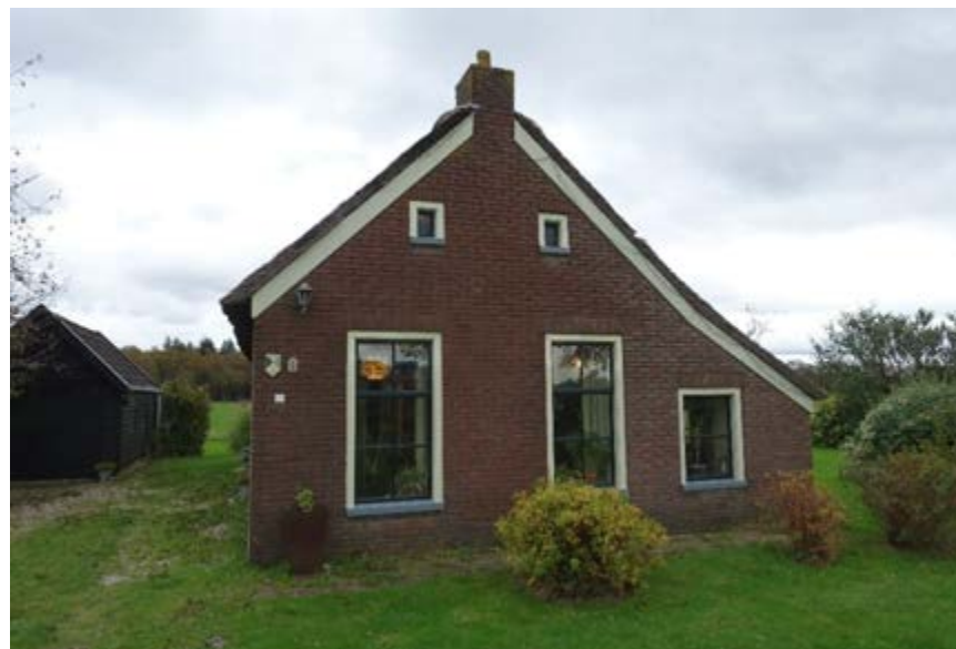
De voorgevel heeft een klamp rond de vermoedelijk nog aanwezige oorspronkelijke gevel.
