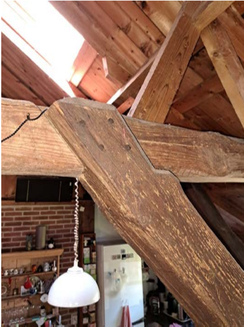
Detail aansluiting korbeel op dekbalk.
