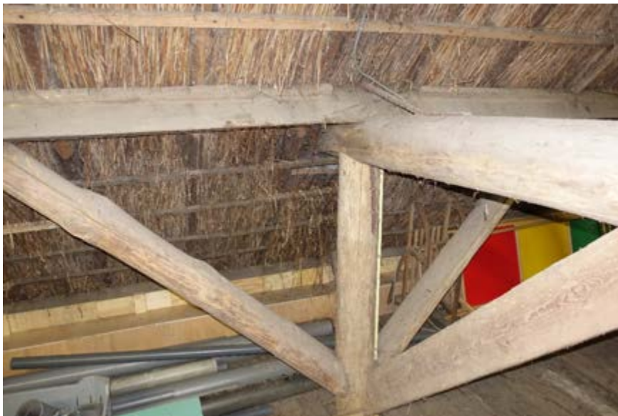
Detail bovenzijde van één van de gebintstijlen onder het linker dakvlak.
