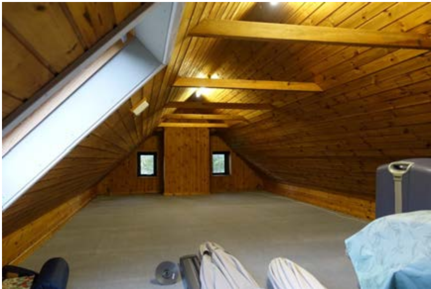
Beeld van de verder volledig afgetimmerde dakconstructie, gezien richting de voorgevel.
