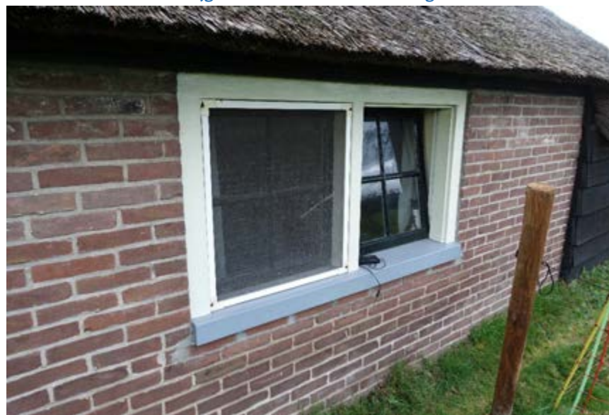
Venster met deels gewijzigde dagkanten in het middendeel van de gevel.
