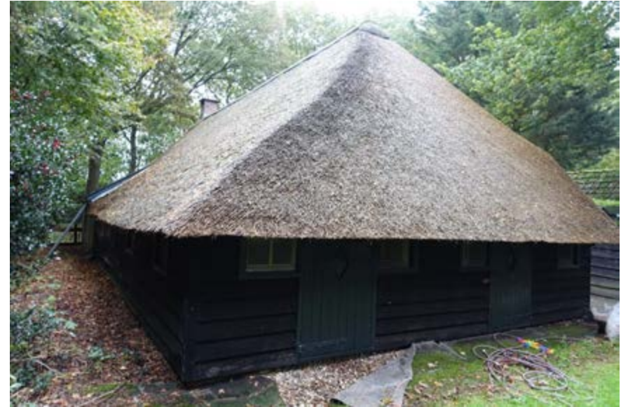
Overzicht van de vernieuwde houten achtergevel.
