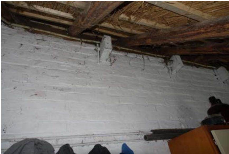
Hogere rechthoekige balken met een kraalprofiel boven de later ingevoegde slaapkamer.
