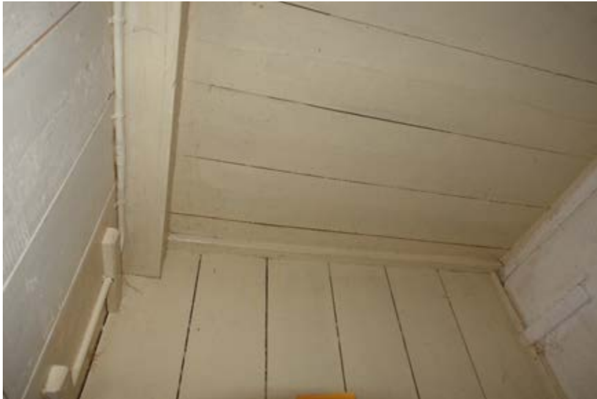
De enkelvoudige balklaag is alleen boven de bedsteden deels zichtbaar.
