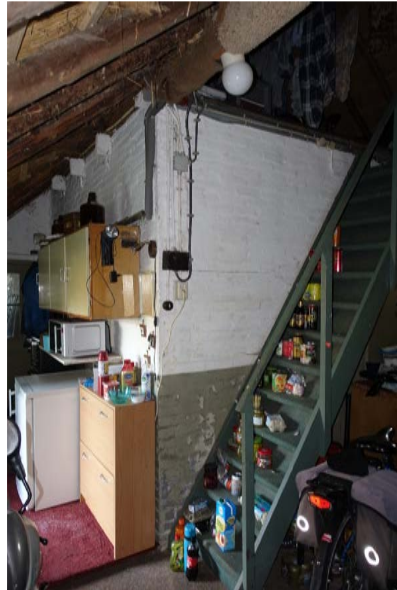
De oorspronkelijke gebintplaat draagt op de latere binnenwanden binnen het bedrijfsgedeelte.
