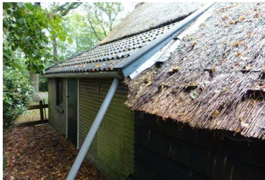
Later aangebouwde zijkamer met pannendak.
