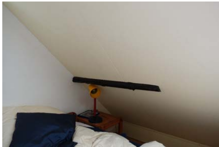
Houten regel aansluitend op de voorgevel.
