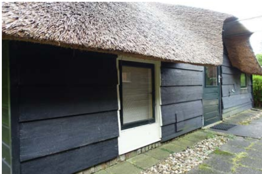
Brede gepotdekselde delen van de vernieuwde achtergevel.
