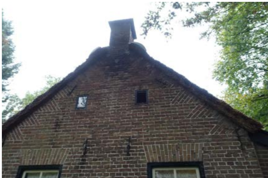
Halfsteens topgevel en schoorsteen.
