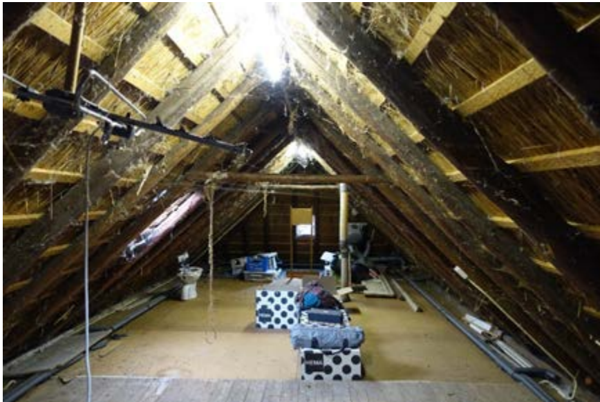
Overzicht dakconstructie richting de achtergevel.
