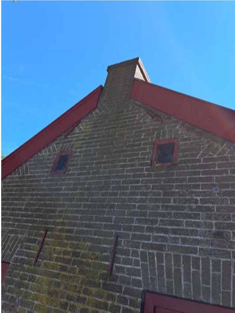
De topgevel is in halfsteens verband gemetseld. De opzet en detaillering zijn bij de vernieuwing van de voorgevel overgenomen.
