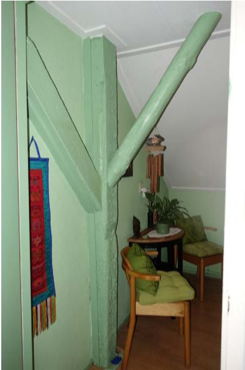
Overzicht gebintstijl van het achterste gebint. De stijl heeft in de voorzijde, onder de rondhouten windschoor, een ondiepe keep.
