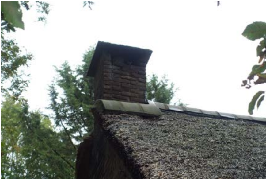
Detail schoorsteen boven de voorgevel.
