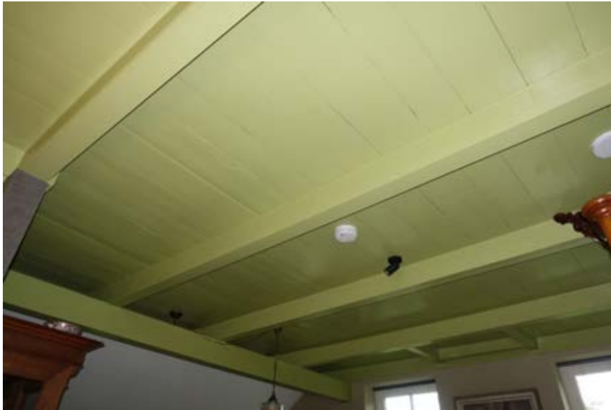
Overzicht balklaag boven de oorspronkelijke woonkamer, richting de zijkamer.
