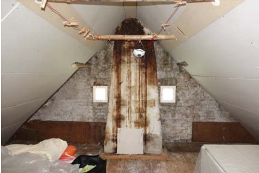
Alleen de vernieuwde haanhouten en twee koppelbalkjes bij de voorgevel zijn zichtbaar.
